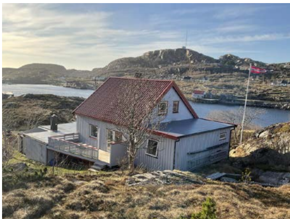
Terreng heller ned mot bolig
