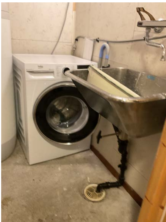
Opplegg på vaskerom
