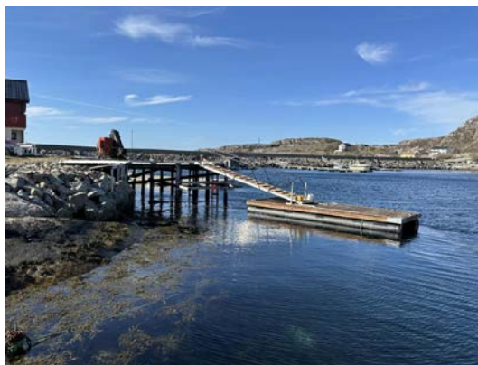
Flytebrygge ved Skjærvøyvågen
