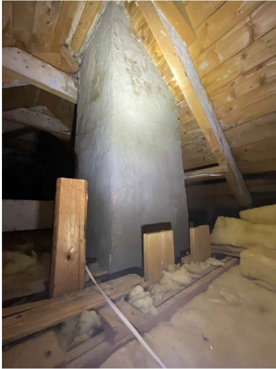
Pipe på kaldloft
