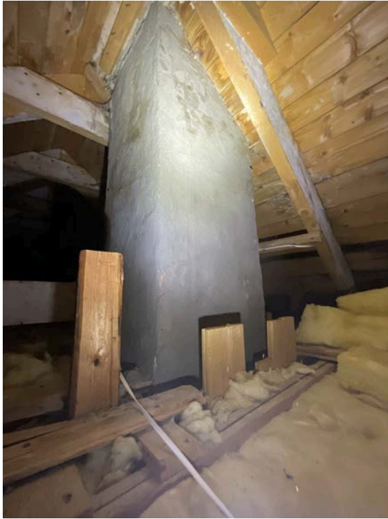
Pipe på kaldloft
