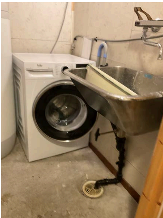
Opplegg på vaskerom
