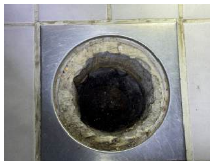
Eldre støpejernsluk i gulv.
