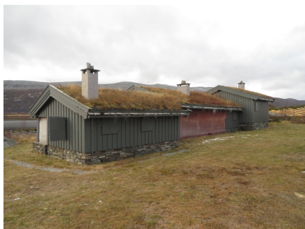
et ses samlet 3 stk piper - alle uten stigetrinn og feierplattformer.
