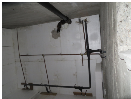
Bildet er tatt fra kjeller og viser gulvet rett under bad, hvor det ses avløpsgjennomføringer for både sluk og toalett samt servant. Som bildet antyder, antas det å være støpt dekke som konstruksjon/etasjeskille i bad.
