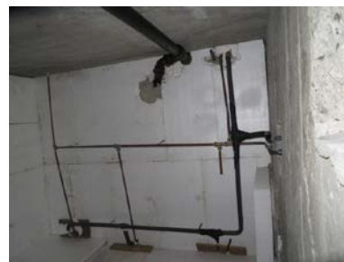
Bildet er tatt fra kjeller og viser gulvet rett under bad, hvor det ses avløpsgjennomføringer for både sluk og toalett samt servant. Som bildet antyder, antas det å være støpt dekke som konstruksjon/etasjeskille i bad.
