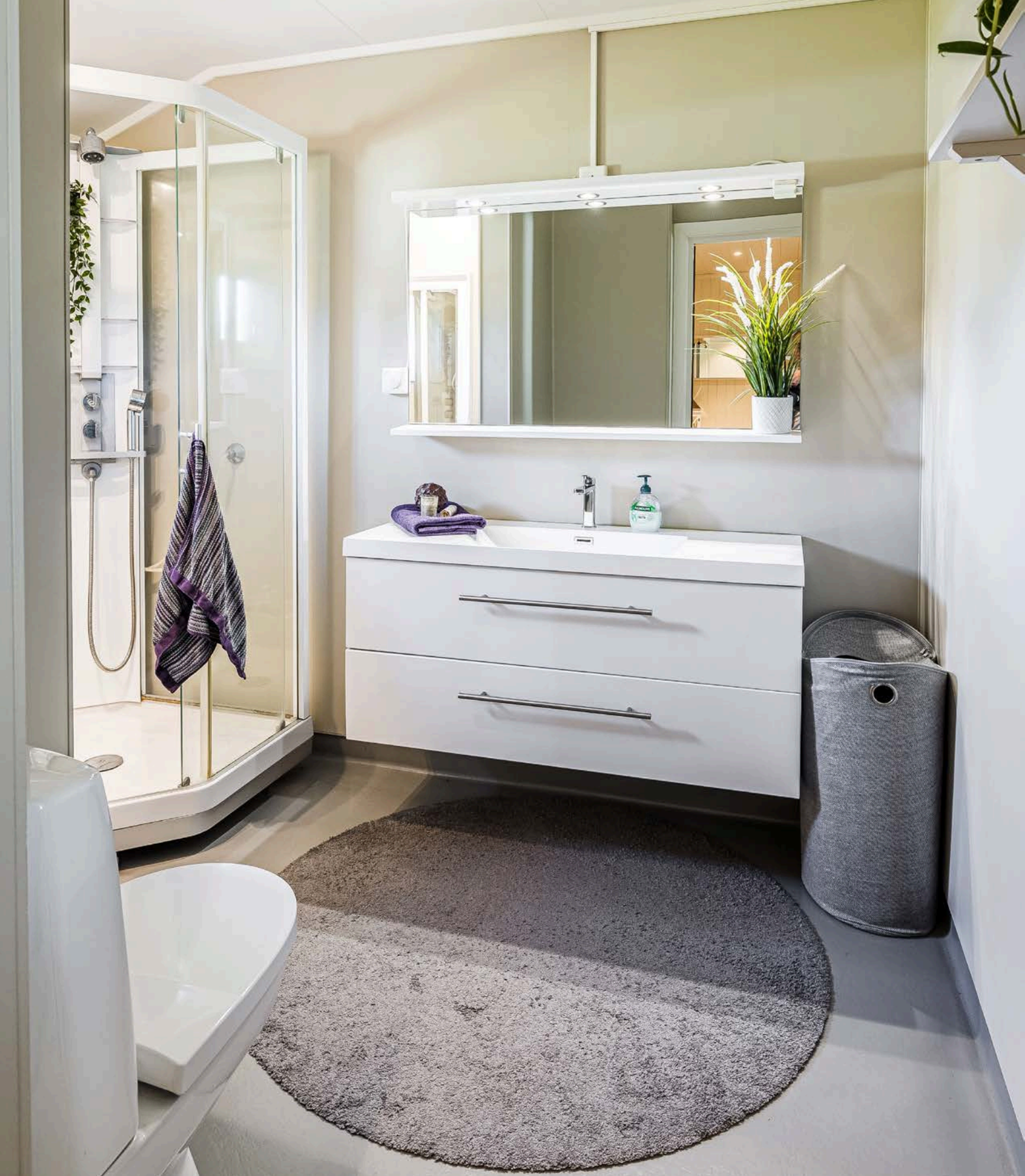
Baderommet har våtromsbelegg på gulv som ble malt med trestjernes gulvmaling i 2019, deilig gulvvarme, våtromsplater på veggene malt med våtromsmaling i 2019 og mekanisk avtrekksvifte.
