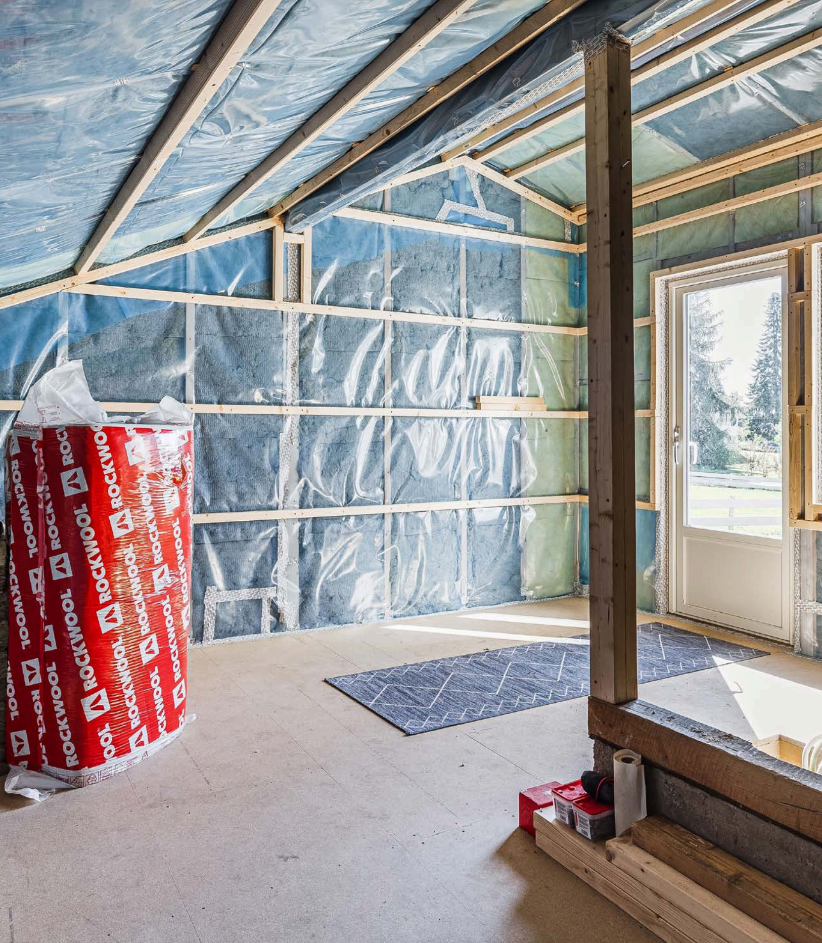
Tidligere garasje og bod som er påbegynt innredet. Rommet er isolert første laget og plastet, gulvet er oppført, isolert og belagt med plater.
