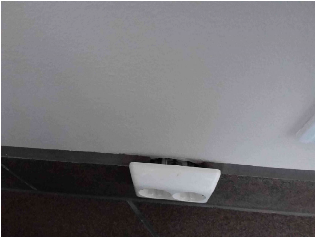
Skjema: "SpareBank1 Brannforebyggende elkontroll" Spørsmål: Merknad Beskrivelse: Vindfanget, Filnavn: IMG_20200528_094933.jpg
