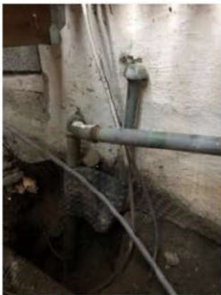
Påfyllingsrør for oljetank
