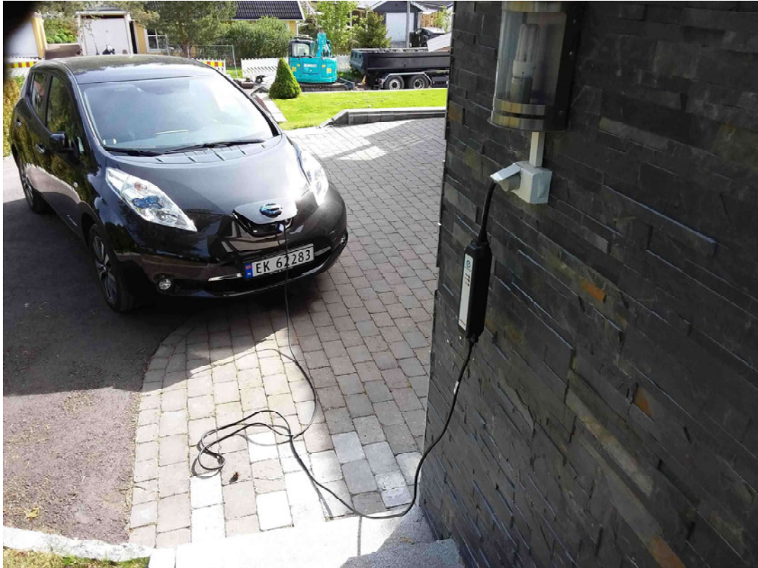
Skjema: "SpareBank1 Brannforebyggende elkontroll" Spørsmål: Merknad Beskrivelse: Elbil, Filnavn: IMG_20200528_095759.jpg
