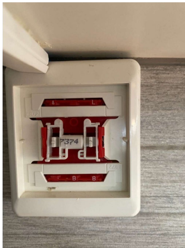
Bilde 25. bryter merket 7374, som er en koding for produksjonsdato. DVS produsert i 2007, uke 37, ukedag 4. DVS montert etter produksjon dvs i en dokumentasjonspliktig periode. Foreligger ingen form for fagmessig lovpålagt dokumentasjon for noen elektroarbeider i boligen.
