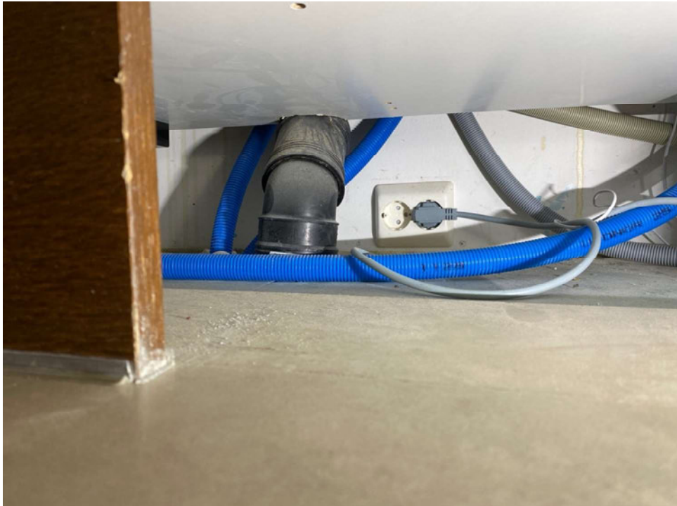
Bilde 17. Lite tilgjengelig koblingspunkt, kjøkken, hovedleilighet. Rør gjennom etasjeskille må evalueres av brannsakkyndig mhp brannsikringstiltak.
