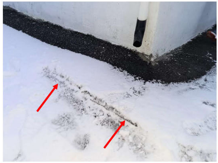
Piler viser betongdekkets kant.
