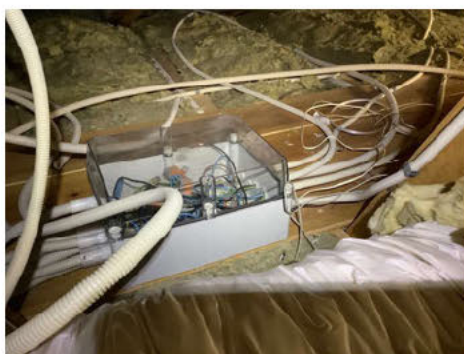
K-rør inn i boks tettes.
