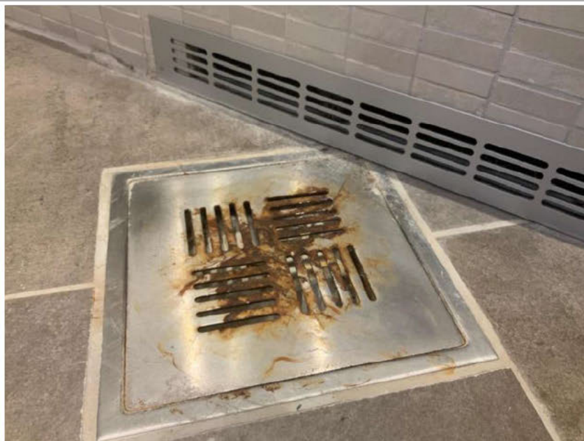
Bad 1. etg. (u.etg.) Sluk frem for innbygget badekar.
