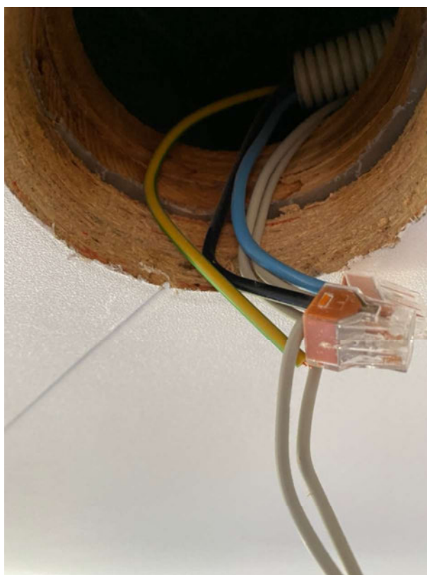
Bilde 35. Eksempel ulovlig kobling i tak. Dårlig kobling i koblingspunktet. Ikke fagmessig utførelse.
