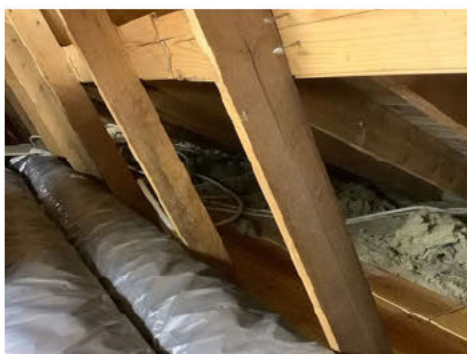
Alle synlige rør isoleres
