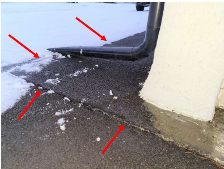
Piler viser betongdekkets kant.
