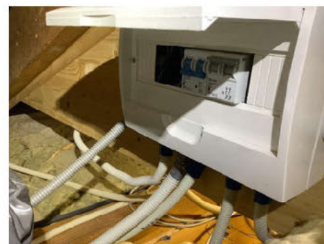
Rør kappes, tettes og skjøtes
