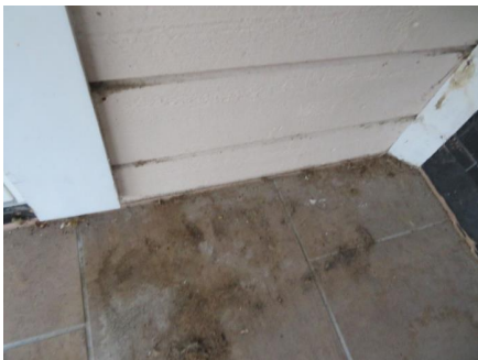
Panelkledning ført ned under fliser.
