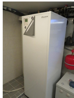
Hovedenhet for vannbåren varme.
