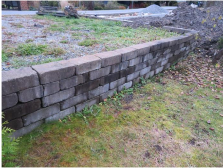
Forstøtningsmur på oversiden av bygget.
