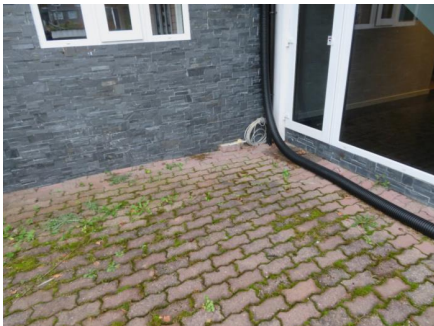
Løsning med bortledning av takvann fra nedløp.
