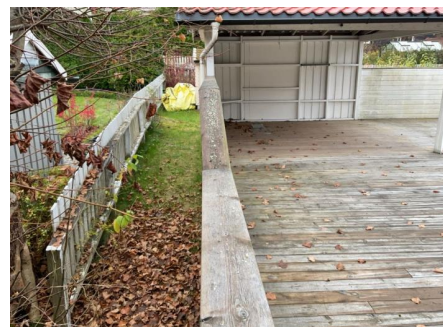
Skjevhet i rekkverk.
