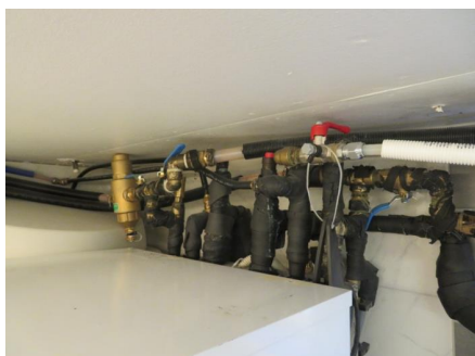
Fordelerskap for gulvvarme i bod i under-etg.
