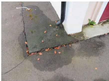
Plate/såle stikker utenfor vegglivet.
