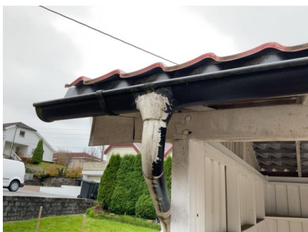
Provisorisk tetting av takrenne/nedløp.
