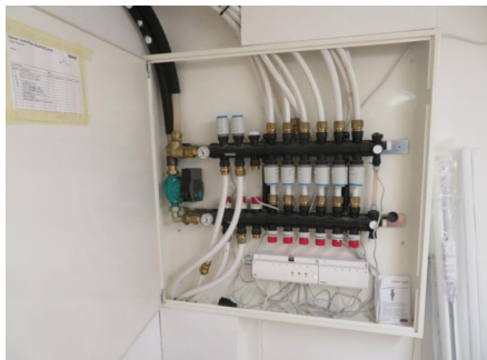
Fordelerskap for gulvvarme i bod i under-etg.
