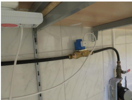
Stengeventil for automatisk vannstopper. Hovedstoppekran.
