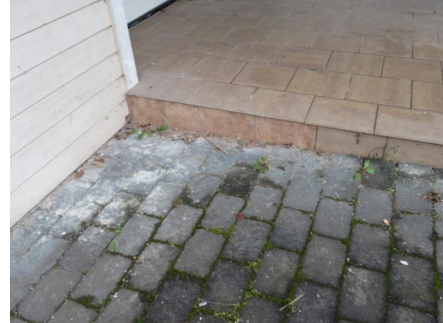
Fall inn mot bygget.
