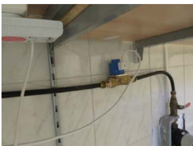
Stengeventil for automatisk vannstopper.
