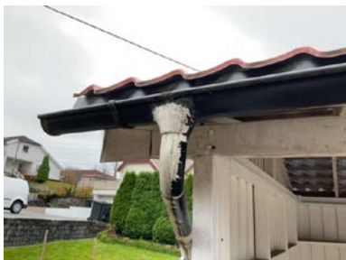
Provisorisk tetting av takenne/nedløp.
