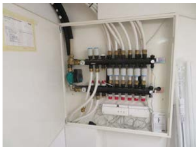
Fordelerskap for gulvvarme i bod i under-etg.
