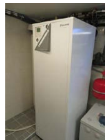
Hovedenhet for vannbåren varme.
