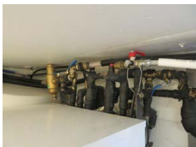
Fordelerskap for gulvvarme i bod i under-etg.
