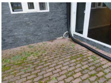
Løsning med bortledning av takvann fra nedløp.
