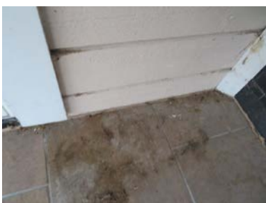
Panelkledning ført ned under fliser.
