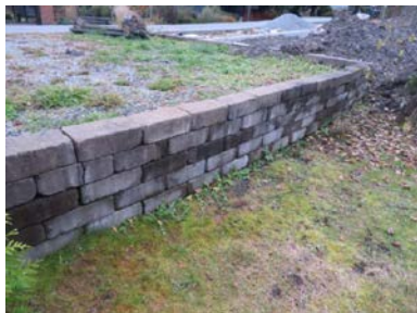
Forstøtningsmur på oversiden av bygget.
