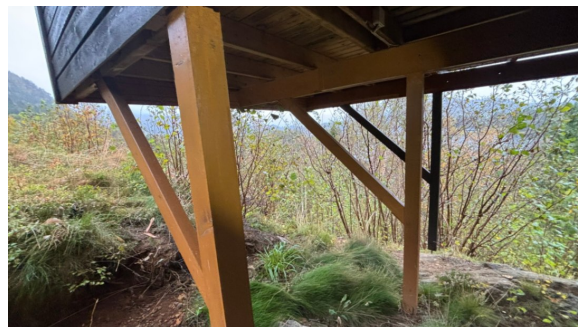
Bærekonstruksjon under boden
