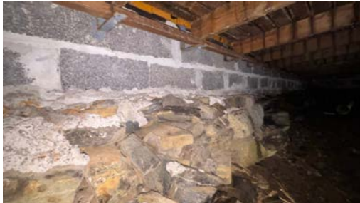
Grunnmuren er plassert på en kombinasjon av fjell og fritt lagt stein
