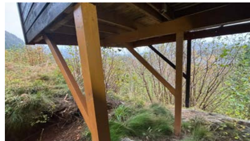
Bærekonstruksjon under boden
