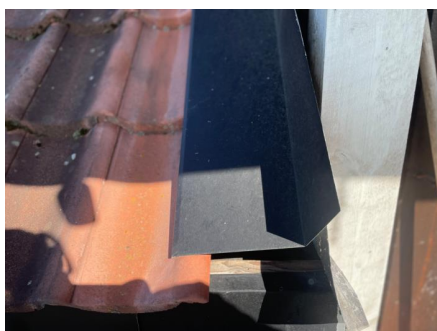
Overgangsbeslag tak/vegg på oppløft.
