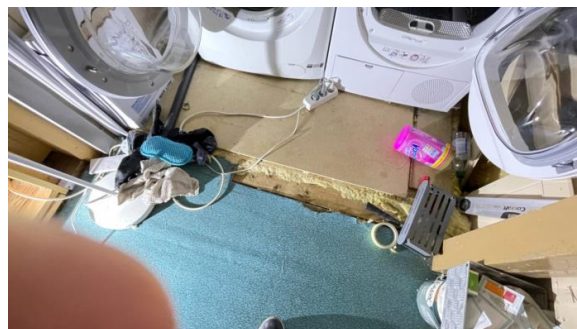
Ganggulv i 2. etasje.
