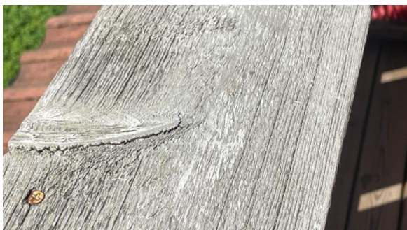
Toppbord på balkongrekkverk.
