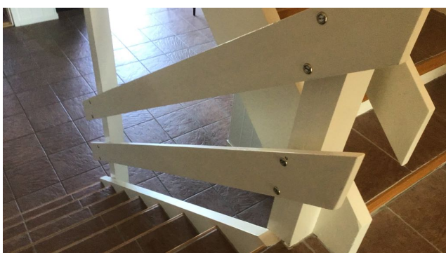
Trapp mellom 1 etg og kjeller
