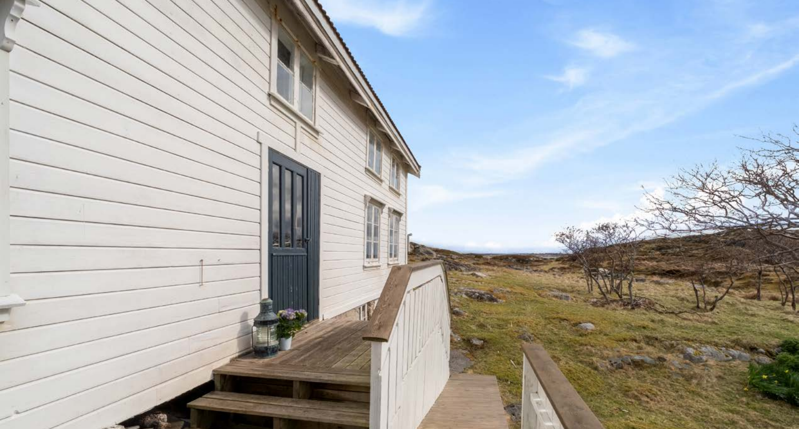
Hovedinngangen er mot sør, med trapp opp til inngangdøren.
