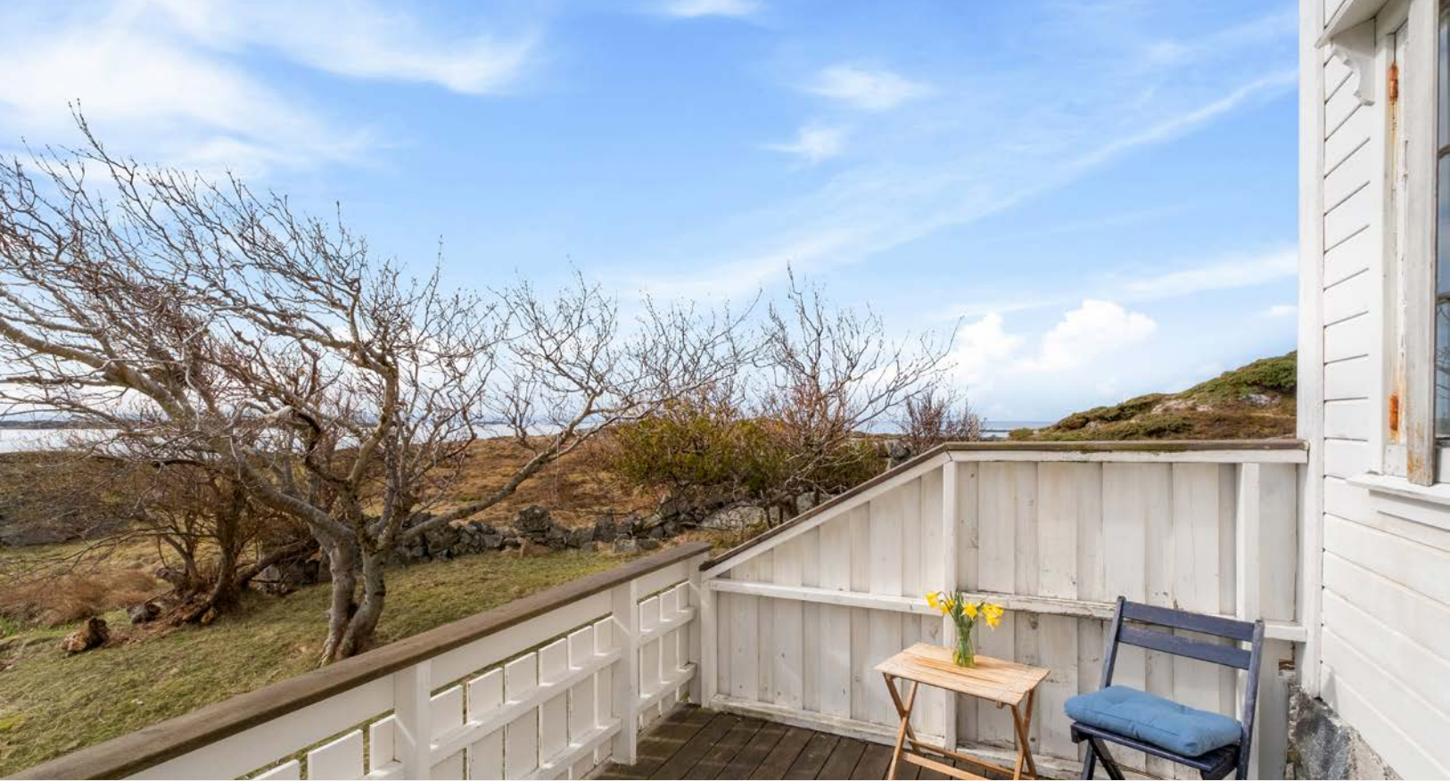
I forbindelse med inngangspartiet er det bygd en terrasse.
