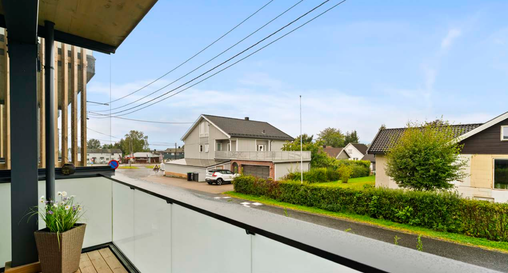
Balkongen som er overbygget, har terrassebord på gulv og moderne rekkverk i stål/aluminium med glassfelt.
