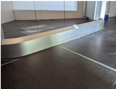
Tett terskel langs dusj
