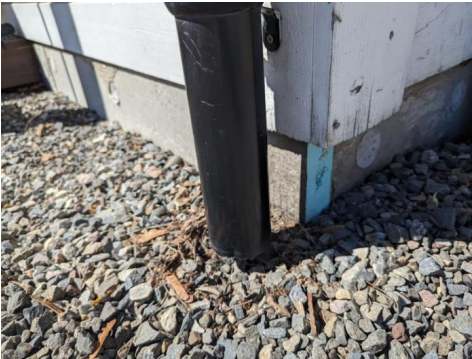
Taknedløp v/ ringmur
