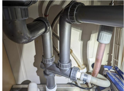
Avløpsrør i kjøkkenbenk
