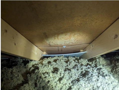
Lufting langs takfot
