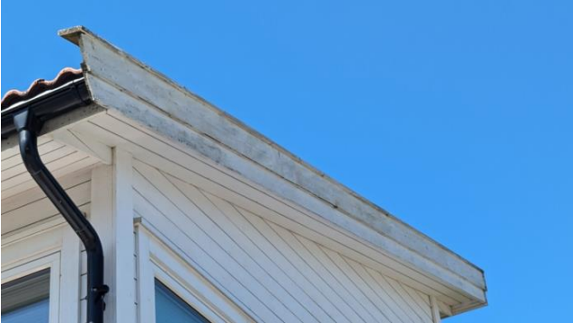
Renner, nedløp og vindskibord
