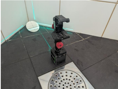
Måling av fallforhold på gulv
