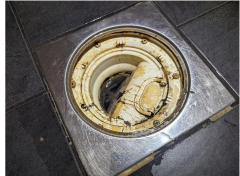
Plastsluk med klemring
