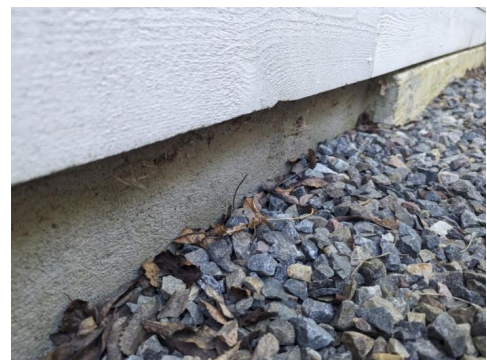
Grunnmur over terreng
