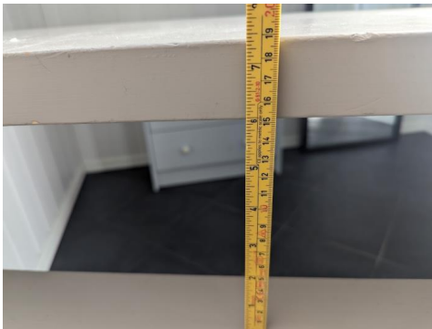
Måling av avstand mellom trappetrinn
