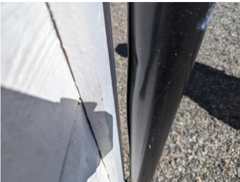
Taknedløp med frostspreng
