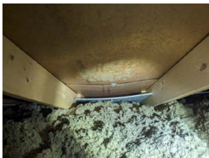
Lufting langs takfot
