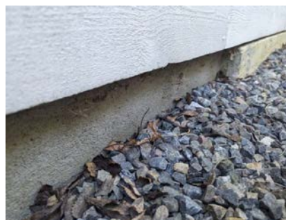
Grunnmur over terreng
