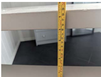
Måling av avstand mellom trappetrinn
