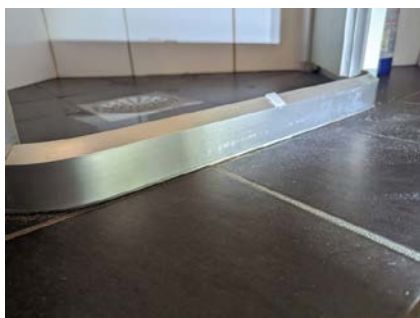
Tett terskel langs dusj
