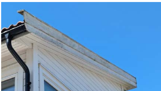
Renner, nedløp og vindskibord
