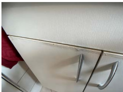
2.ETASJE > BAD - 7.9M2
