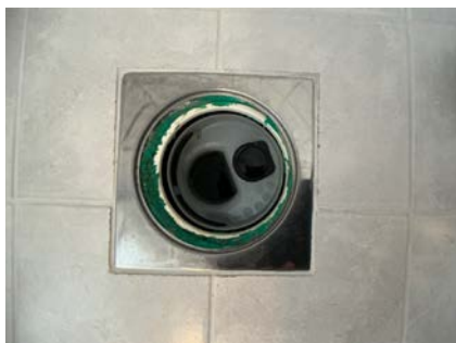
2.ETASJE > BAD - 7.9M2
