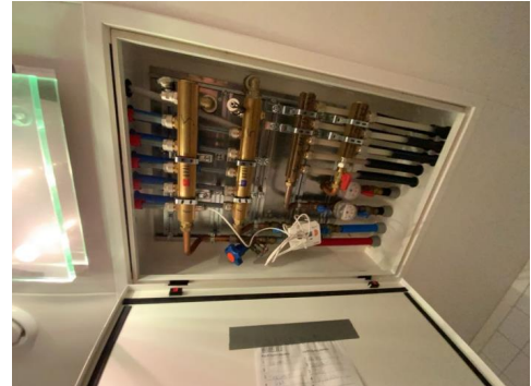
Besiktigelse av røropplegg.
