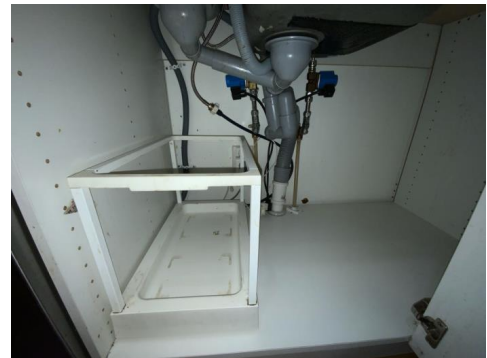
Besiktigelse av røropplegg.
