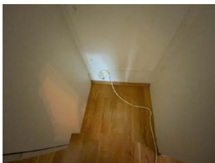
Kontroll bak kjøleskap. Ingen tegn til fuktskader på befaringdagen.
