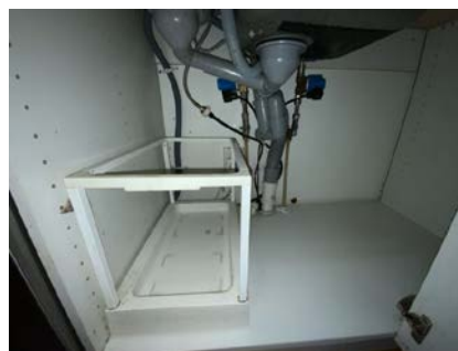
Besiktigelse av røropplegg.
