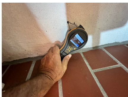
Målt på nord vegg i stue
