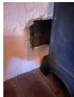
Det har vært en sprekk i siden på ovnen i spiseetuen, denne er blitt utbedret i forbindelse med renoveringen av ovnen i 2010.
