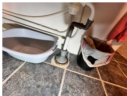
Eldre rør opp av gulv.
