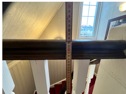
Retur rekkverk på 2 etasjen
