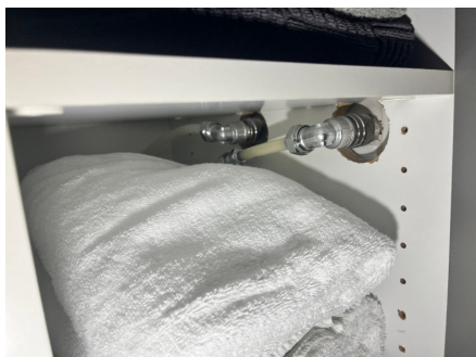
Rørgjennomføringer i vegg.
