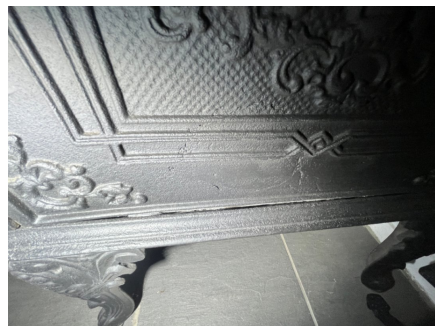
Det har vært en sprekk i siden på ovnen i spiseetuen, denne er blitt utbedret i forbindelse med renoveringen av ovnen i 2010.
