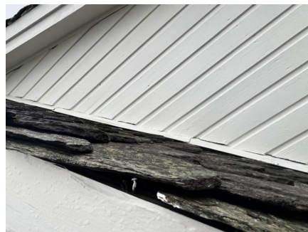
Kledning helt ned mot takteking
