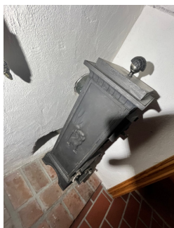
Avstand til brennbart materiale er mindre enn 30 cm.
