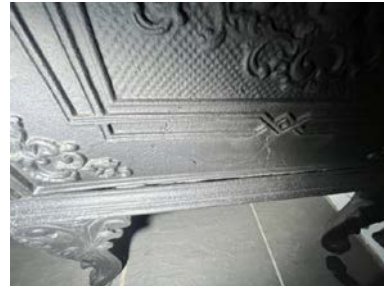
Det har vært en sprekk i siden på ovnen i spisestuen, denne er blitt utbedret i forbindelse med renoveringen av ovnen i 2010.
