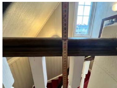
Retur rekkverk på 2 etasjen
