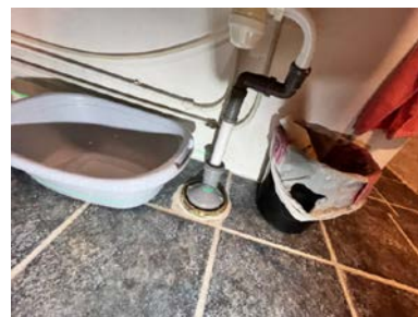
Eldre rør opp av gulv.
