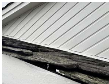
Kledning helt ned mot taktekking
