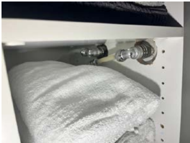
Rørgjennomføringer i vegg.
