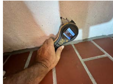
Målt på nord vegg i stue
