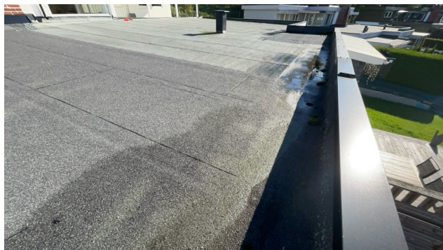
Besiktigelse av taktekke.
