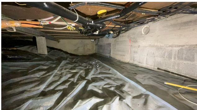
Besiktigelse av kryprom.
