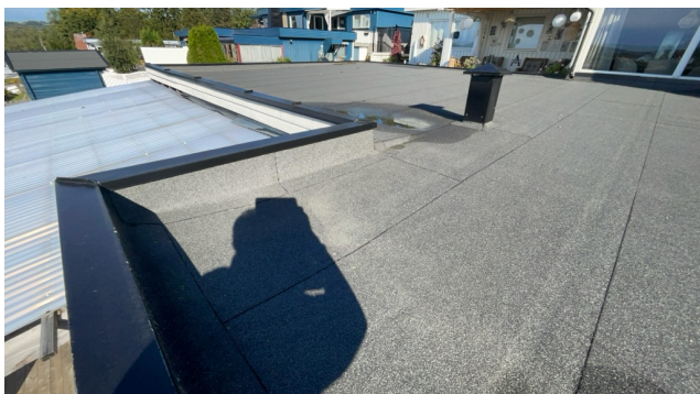
Besiktigelse av taktekke.
