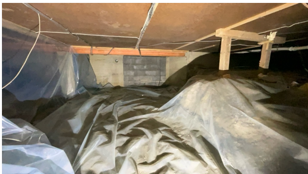
Besiktigelse av kryprom.
