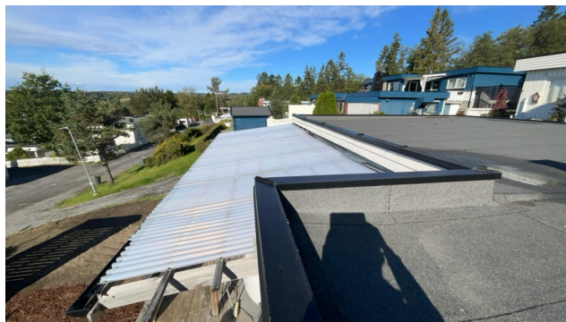
Besiktigelse av taktekke.
