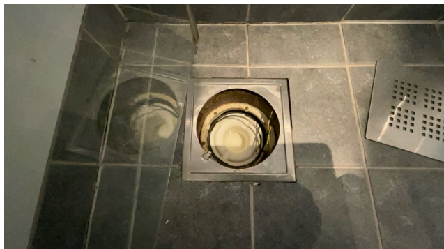
Kontroll av sluk.
