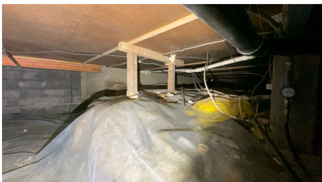
Besiktigelse av kryprom.
