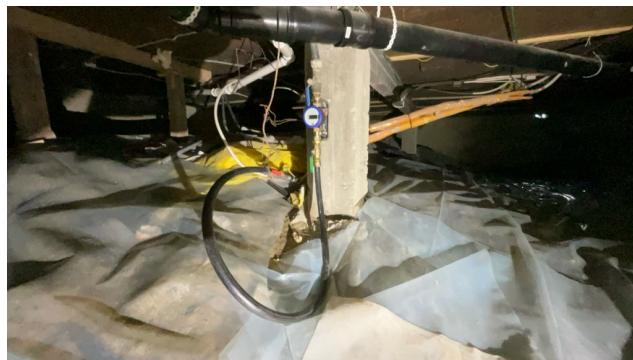
Besiktigelse av røropplegg.
