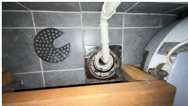
Kontroll av sluk.
