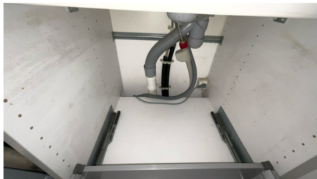
Besiktigelse av røropplegg.
