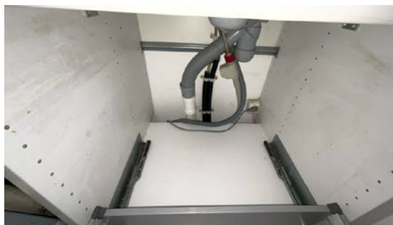
Besiktigelse av rørøpplagg.
