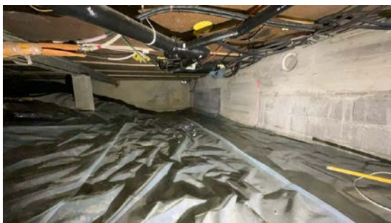
Besiktigelse av kryprom.
