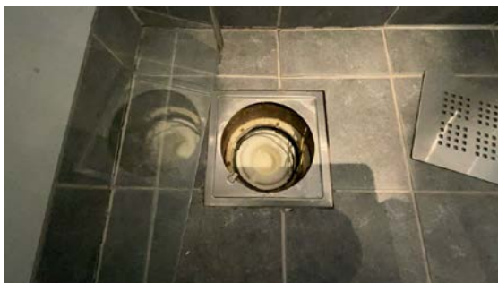
Kontroll av sluk.
