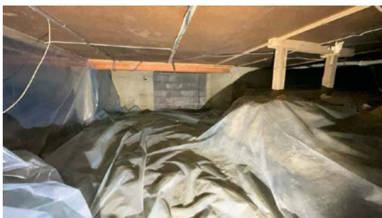
Besiktigelse av kryprom.
