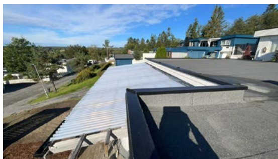
Besiktigelse av taktekke.
