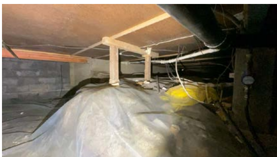
Besiktigelse av kryprom.
