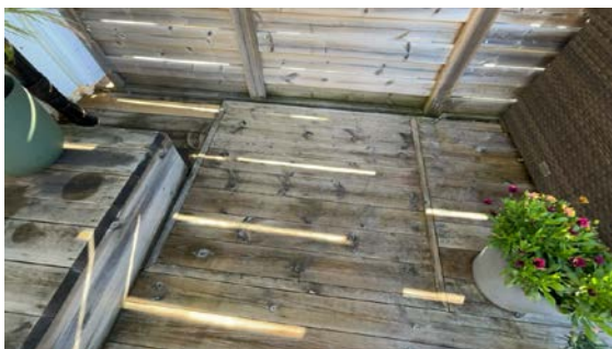
Drenskum er plassert under terrassen.
