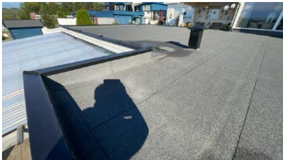
Besiktigelse av taktekke.
