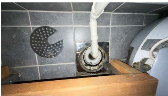
Kontroll av sluk.
