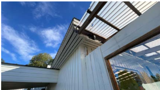
Synlige luftespalter i gesimskasser.
