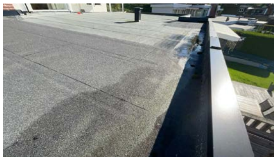
Besiktigelse av taktekke.
