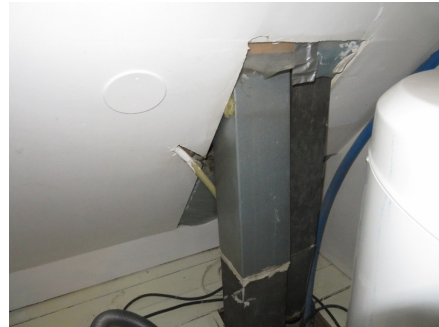
Gjennomføring av kanaler i tak.
