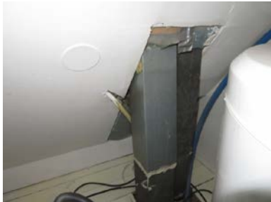
Gjennomføring av kanaler i tak.
