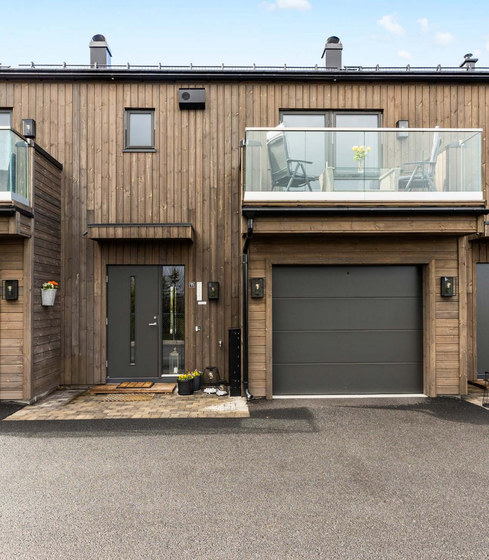
Integrert garasje i 1. etasje.
