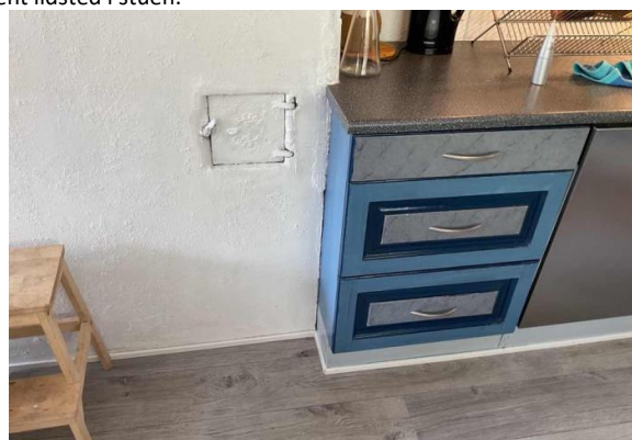
Sotluke på kjøkken.
