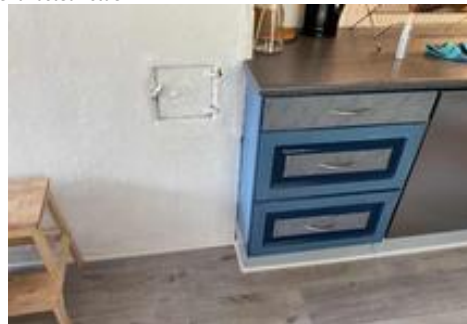
Sotluke på kjøkken.
