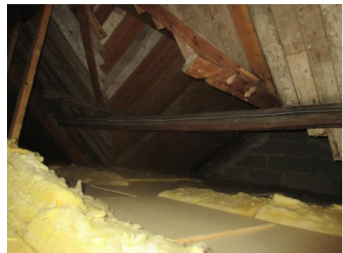
Deler av takkonstruksjonen
