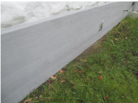
Deler av grunnmur.
