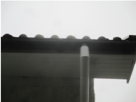
Takrenner av plast på baksiden av boligen.
