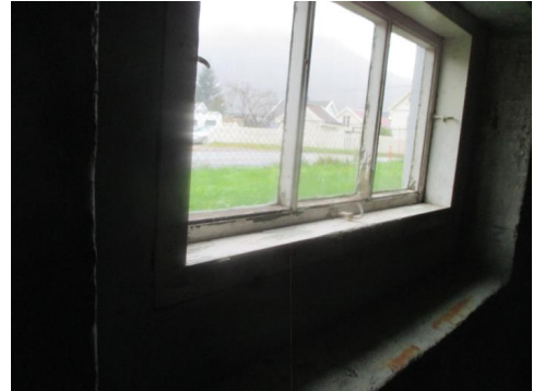
Eldre slitte kjellervinduer.
