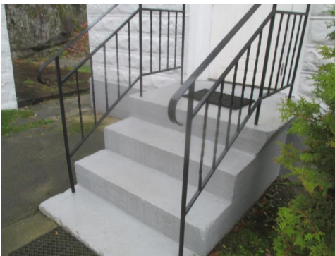
Støpt trapp til inngangsparti.
