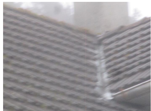
Deler av taktekingen i mot vei.
