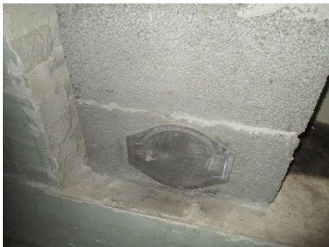
Sotluke i grovkjeller.
