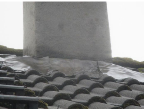
Bunnbeslag på pipe over tak.
