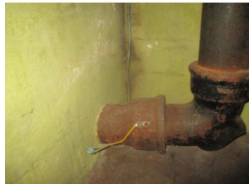
Eldre avløpsrør ut av grunnmur.
