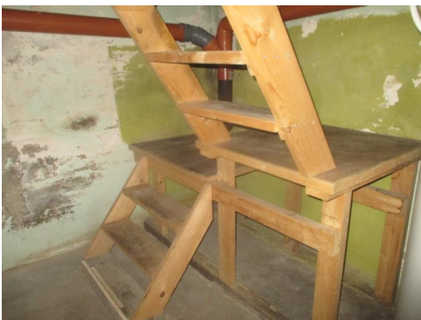
Enkel plassbygget trapp til grovkjeller.
