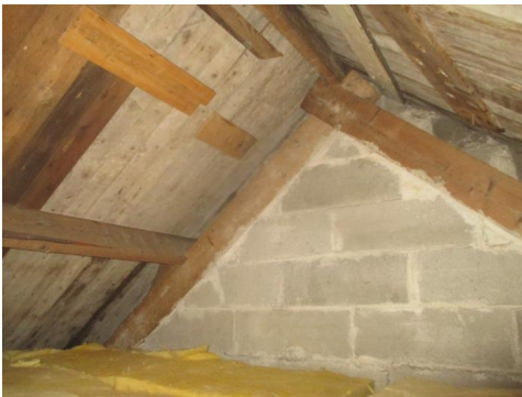
Gavlvegg av sementsteinsblokker.
