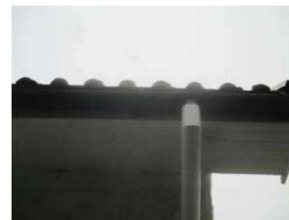
Takrenner av plast på baksiden av boligen.
