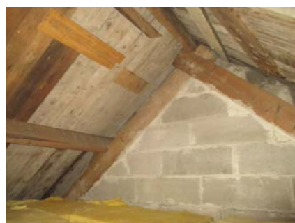
Gavlvegg av sementsteinsblokker.
