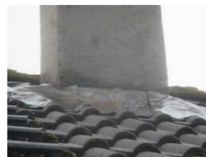
Bunnbeslag på pipe over tak.
