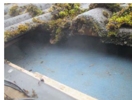
Deler av undertekkingen på baksiden.
