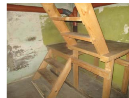
Enkel plassbygget trapp til grovkjeller.
