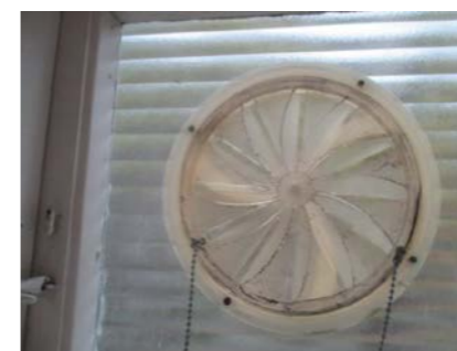
Ventil i vindu. (må ta av innvendig varevindu)
