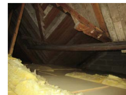
Deler av takkonstruksjonen
