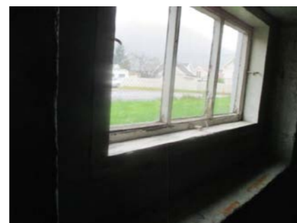
Eldre slitte kjellervinduer.
