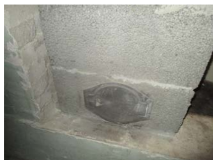
Sotluke i grovkjeller.
