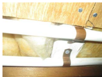
Kobberrør med plastkappe.
