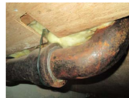
Noe eldre soilrør.
