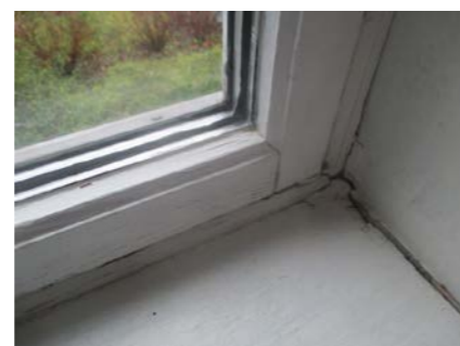
Kondensmerker innvendig.
