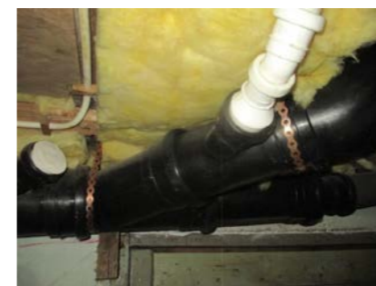
Det meste av avløpsrør er av plast.
