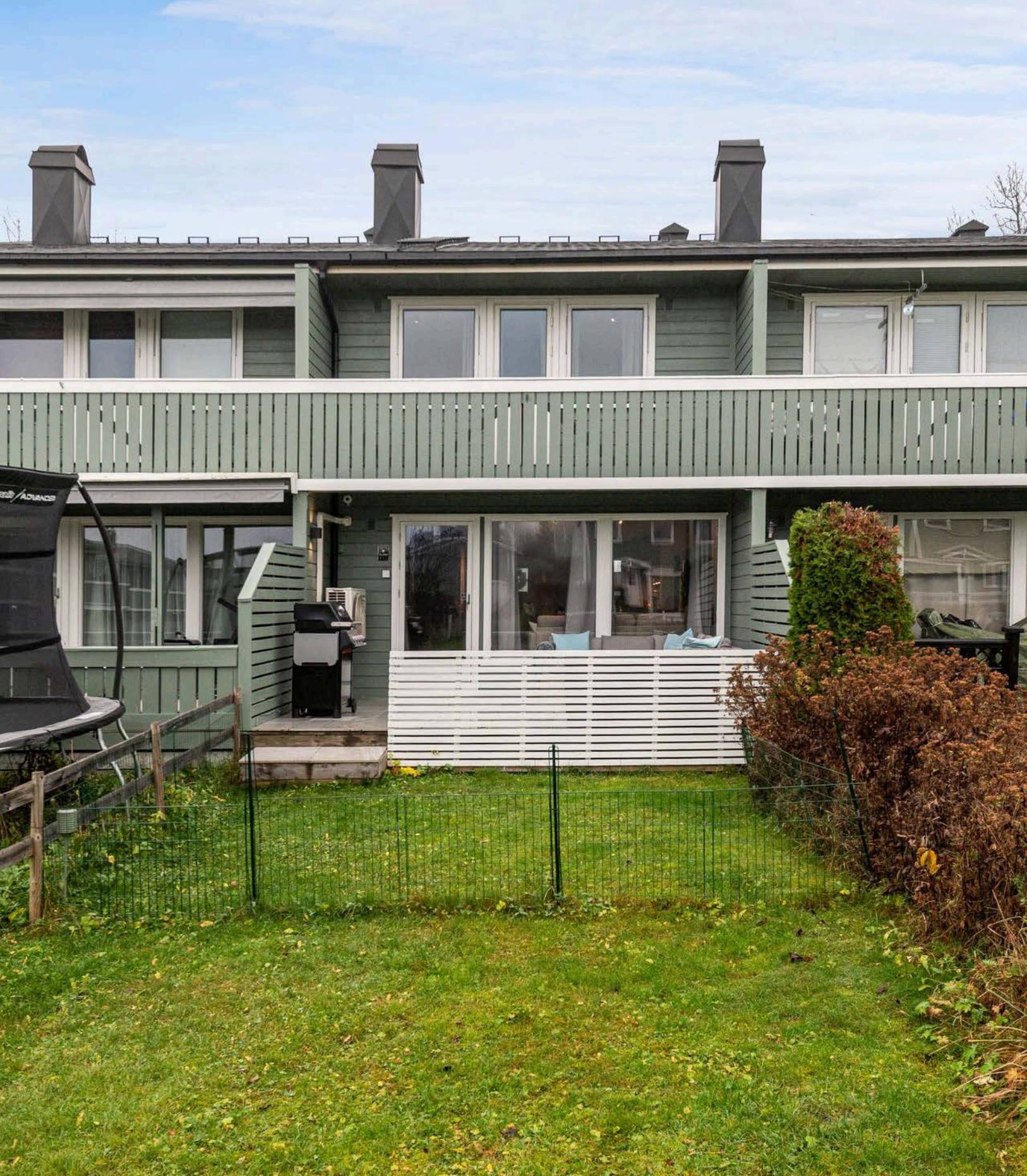
Flislagt terrasse utenfor stue. Det hører også til en liten hage.
