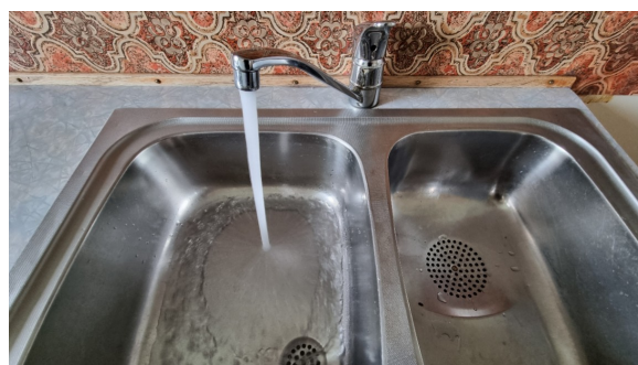
Kontroll av vanntrykk og avrenning.
