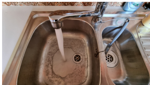
Kontroll av vanntrykk og avrenning.
