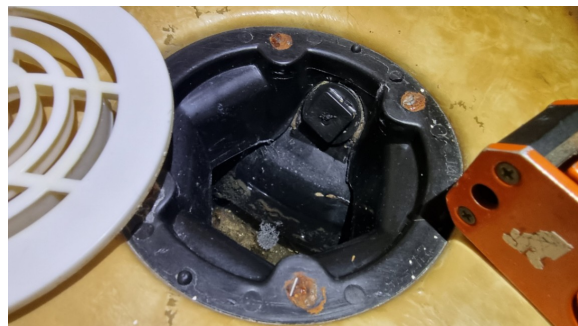
Kontroll av sluk.
