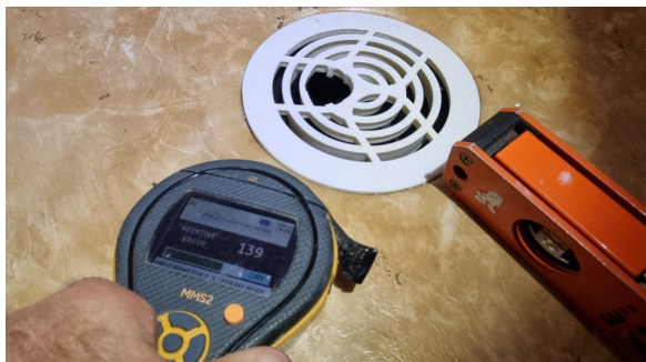
Fuktmåling i gulvet i dusjnisen, ingen unormale fuktverdier ble registrert
