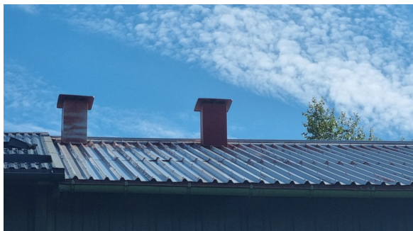
Visuell besiktelse av taket.
