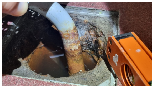
Kontroll av sluk.
