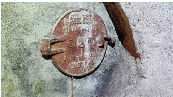
Sotluke i kjeller.
