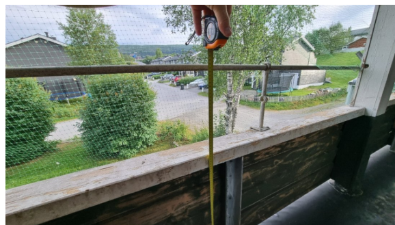
Måling av høyde på rekkverk.
