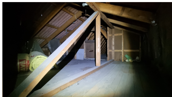
Inspeksjon av kaldloftet
