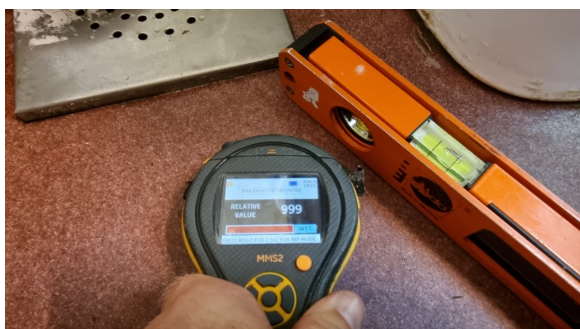
Fuktmåling i gulvet, forhøyede fuktverdier ble registrert.
