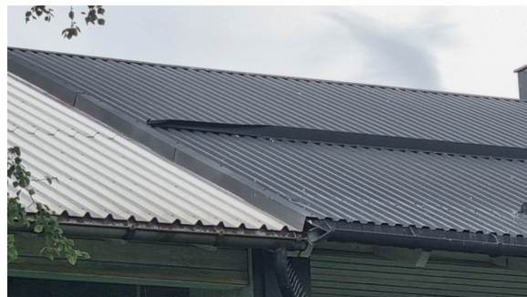
Visuell besiktelse av taket.
