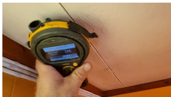
Fuktmåling i fuktskadet himling, ingen unormale fuktverdier ble registrert ved befaring.
