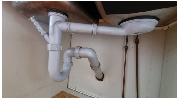
Kontroll av røropplegg under oppvaskkummen.
