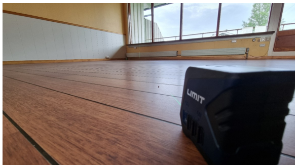
Måling av eventuelle skjevheter med krysslaser.
