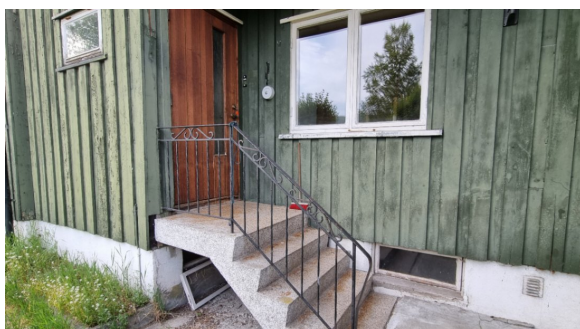
Trapp foran hovedinngangsdøren.
