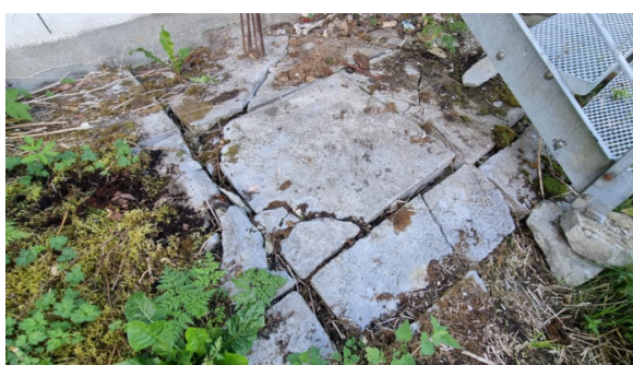
Trappen har provisorisk fundamentering
