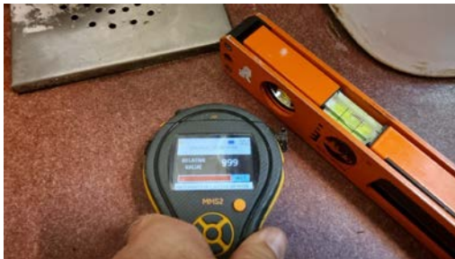
Fuktmåling i gulvet, forhøyede fuktverdier ble registrert.
