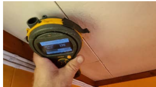
Fuktmåling i fuktskadet himling, ingen unormale fuktverdier ble registrert ved befaring.
