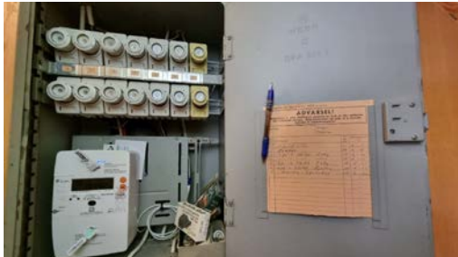
Kontroll av el-skapet i opprinnelige del.
