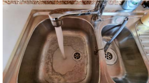
Kontroll av vanntrykk og avrenning.
