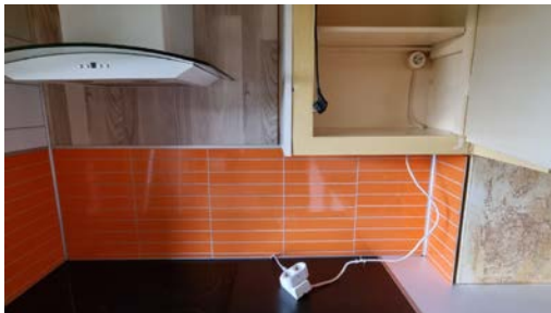
Stedvis provisoriske el-løsninger.
