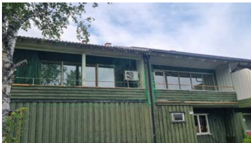
Altaner er oppført utenfor fasade sør.
