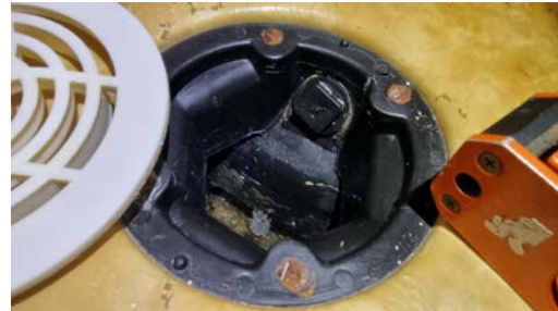
Kontroll av sluk.
