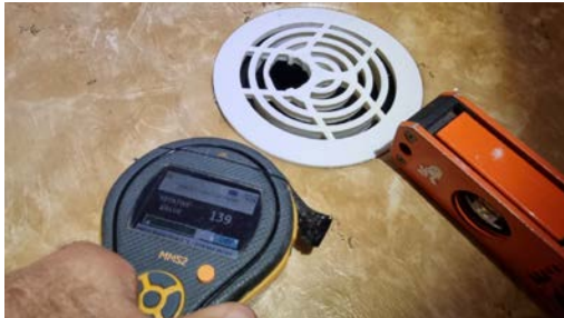
Fuktmåling i gulvet i dusjnisen, ingen unormale fuktverdier ble registrert
