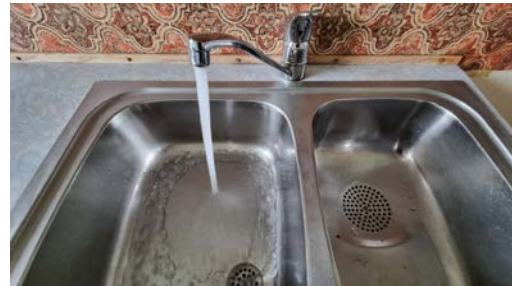
Kontroll av vanntrykk og avrenning.
