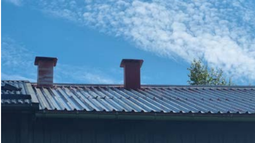
Visuell besiktelse av taket.
