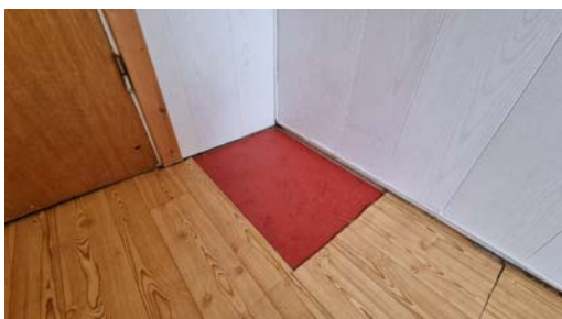
Delvis manglende belegg i det ene soverommet.
