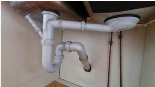
Kontroll av røropplegg under oppvaskkummen.
