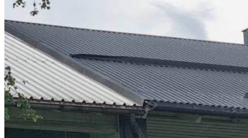
Visuell besiktelse av taket.
