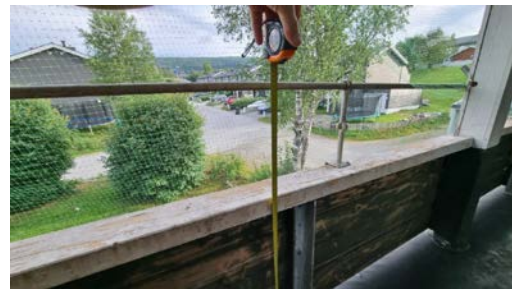
Måling av høyde på rekkverk.
