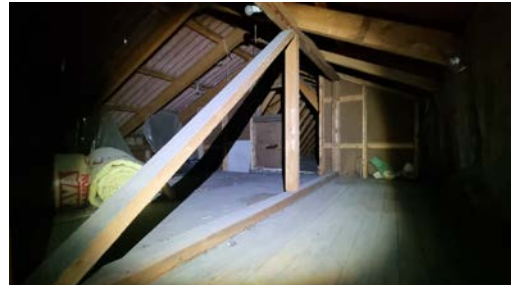
Inspeksjon av kaldloftet
