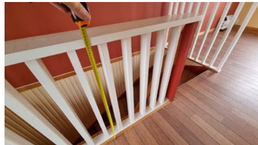
Måling av høyde på rekkverk.
