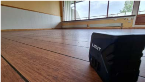
Måling av eventuelle skjevheter med krysslaser.
