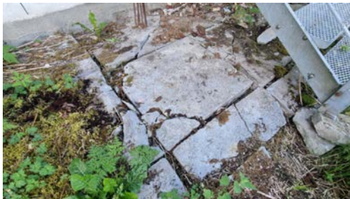
Trappen har provisorisk fundamentering
