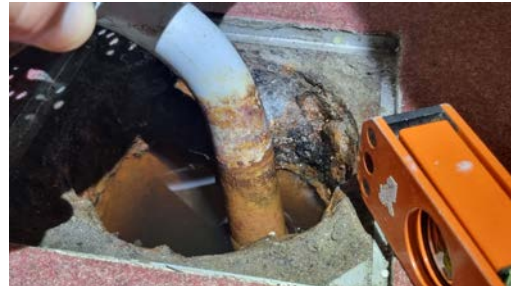
Kontroll av sluk.
