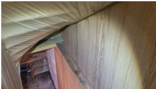
Det er montert presenning under trappen mellom 1. etasje og 2. etasje i opprinnelige del.
