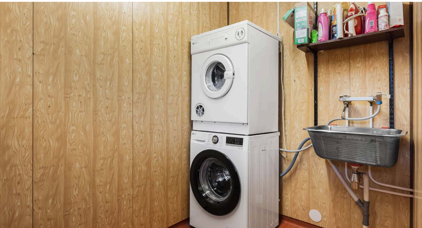
Eldre vaskerom med våtromsbelegg på gulv og våtromsplater på veggene. Det er ESWA varmemefolie i gang, vaskerom og toalett.
