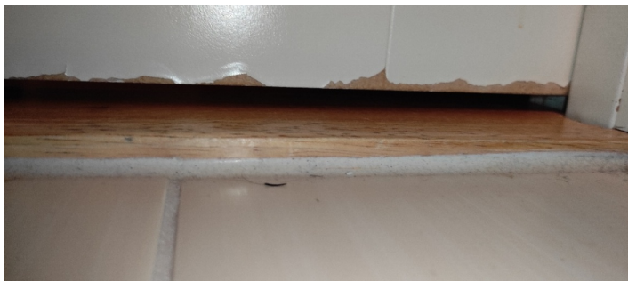
Kontroll av høyde på luftespalte under døren.
