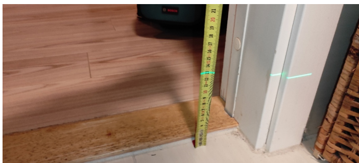
Kontroll av fall mot sluk.
