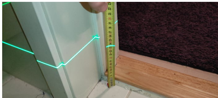
Kontroll av fall mot sluk.
