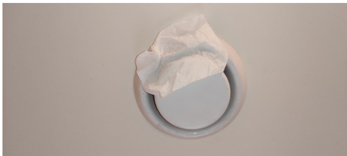
Funksjonstest av avtrekk.
