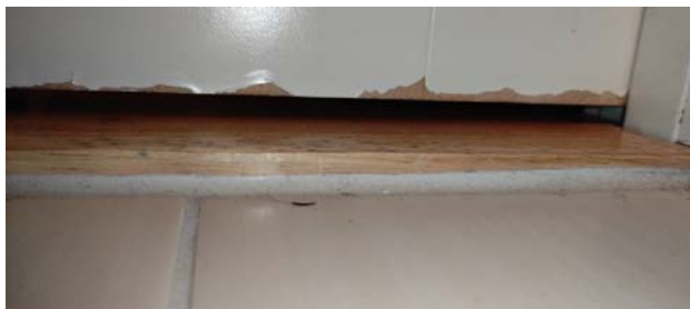
Kontroll av høyde på luftespalte under døren.
