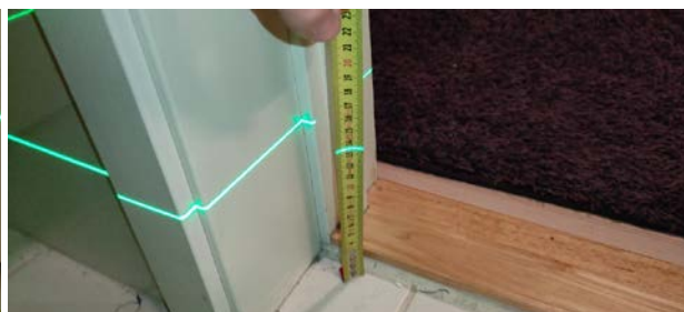
Kontroll av fall mot sluk.
