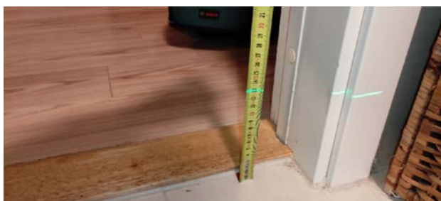
Kontroll av fall mot sluk.
