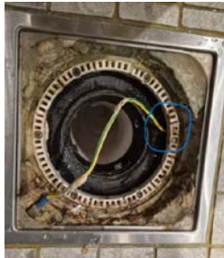
Plastsluk med jordledning i klem
