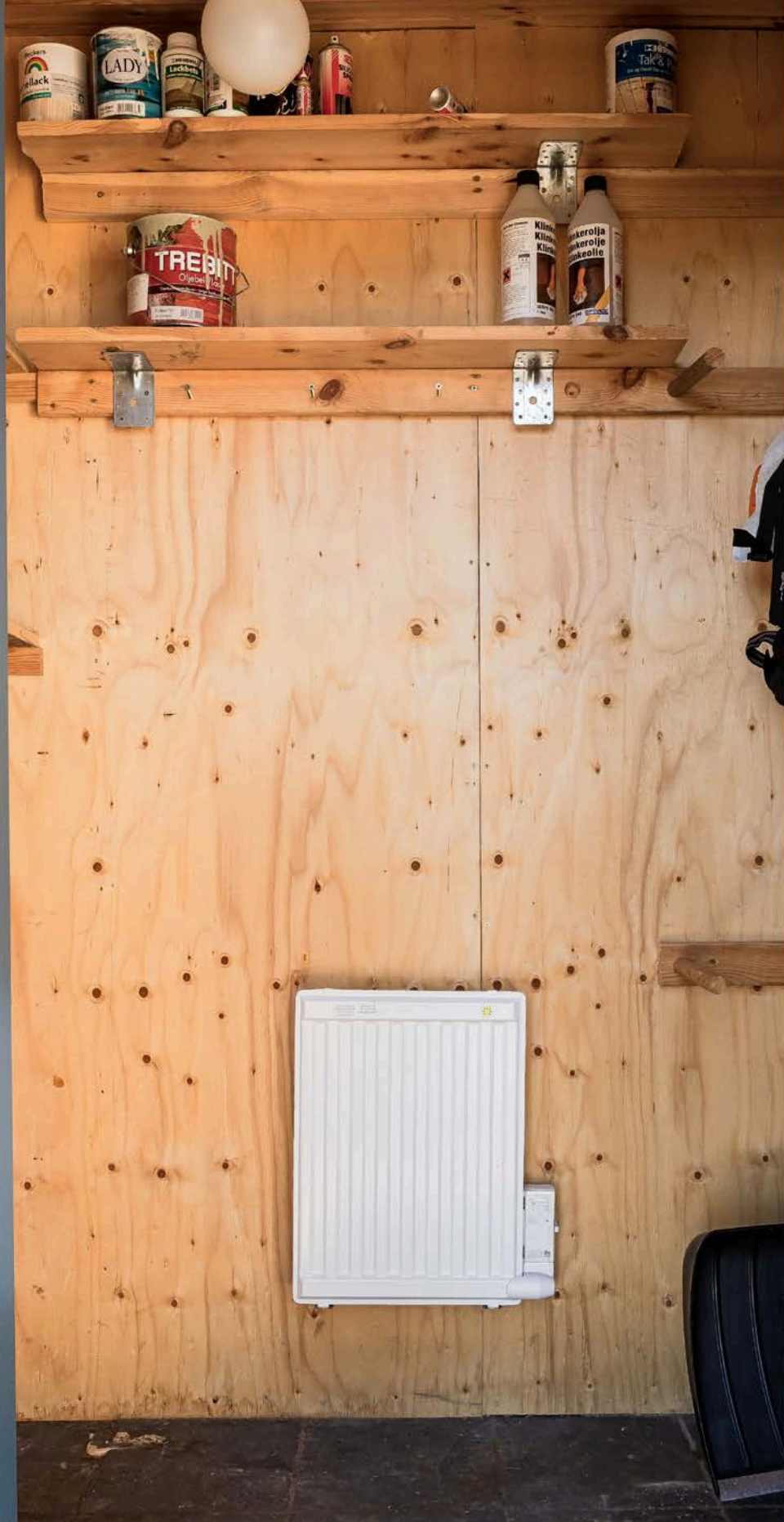
Praktisk utvendig bod med flislagt gulv og hyller for oppbevaring.
