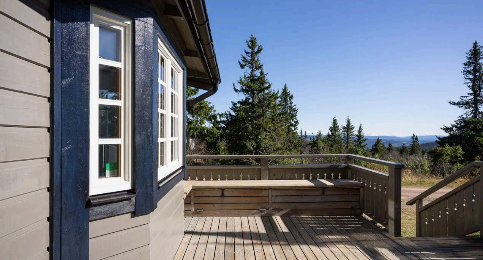
Terrassen som var ny i 2010 har impregnerte terrassebord på gulv og en plassbygget sittebenk mot sydøst.
