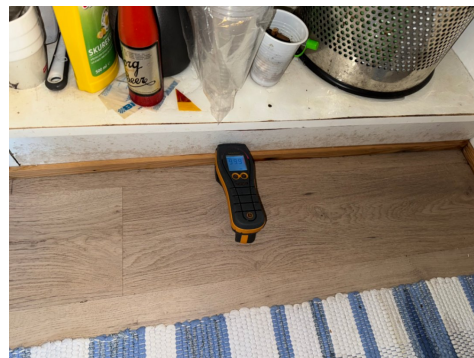
Fuktskadede sokkel
