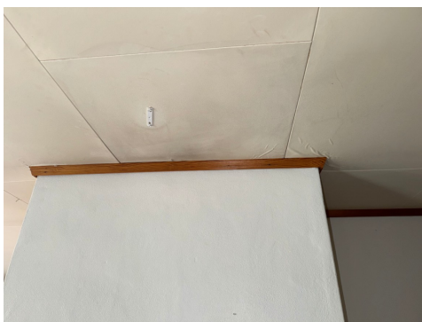
Skader i tak ess plater/folie
