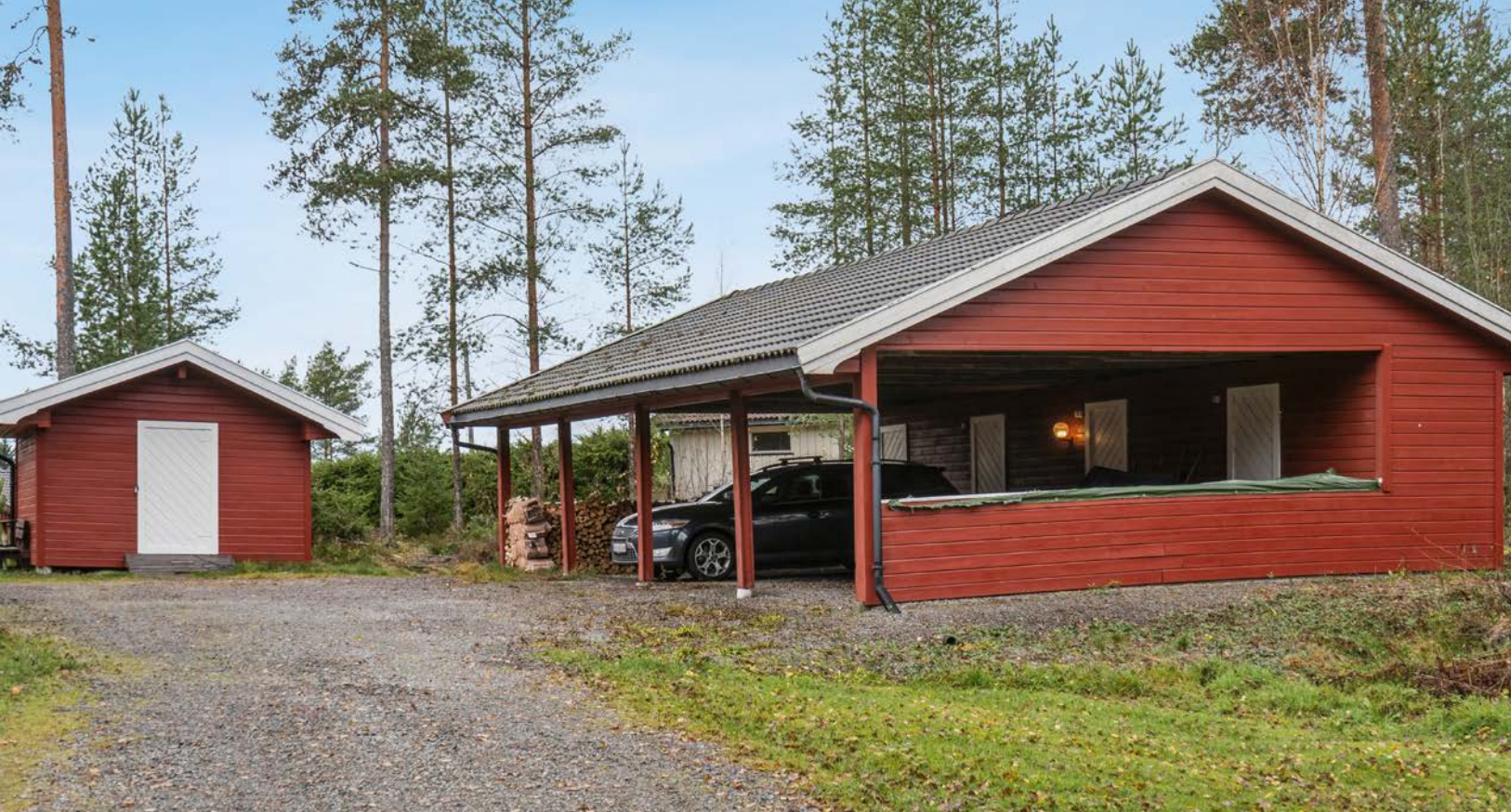
Carportanlegg med boder og enkeltstående fellesbod
