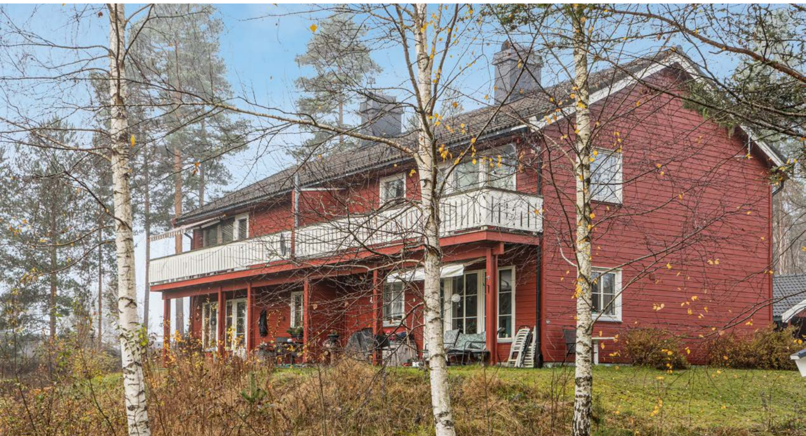
Firemannsboligen er beliggende på Hallbekken på Skotterud.
