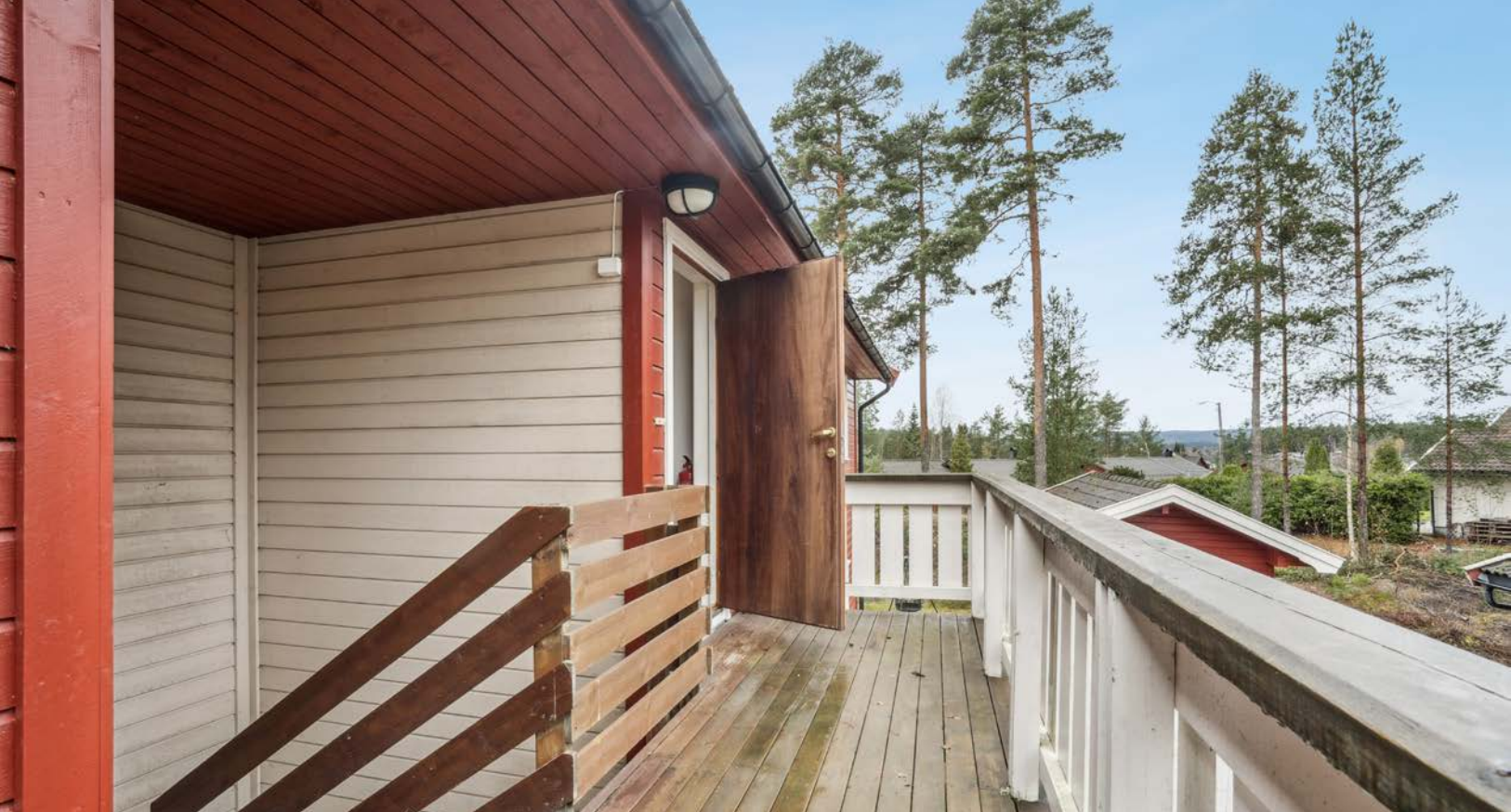
Det er to 3-roms leiligheter og to 2-roms leiligheter i bygget.
