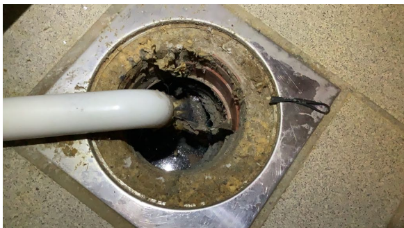
Plastsluk, uten synlig tettesjikt rundt sluk.
