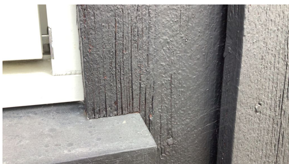
Omramming er ført helt ned til vannbrett.
