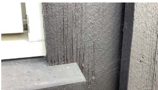
Omrømming er ført helt ned til vannbrett.
