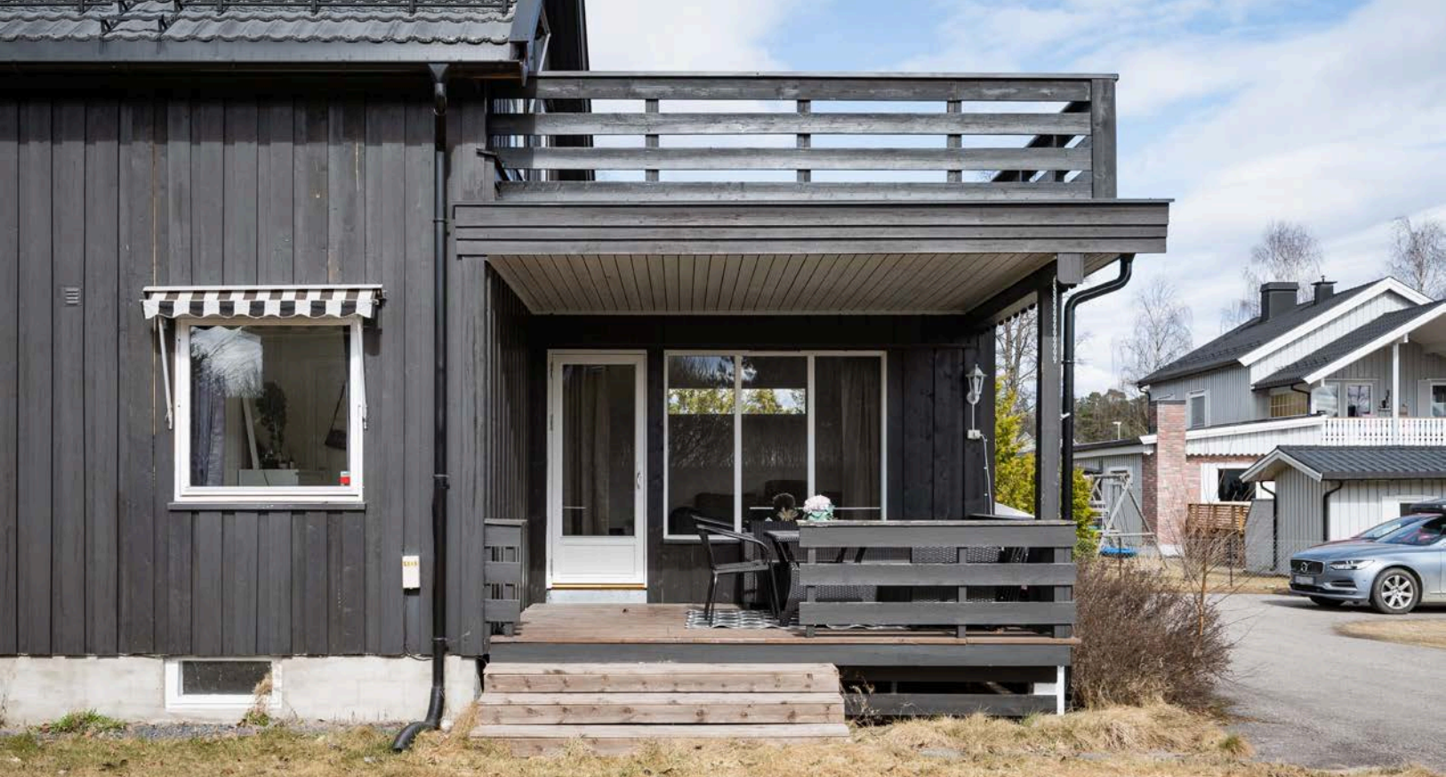
Over stuen har boligen også en stor og solrik takterrasse på 28m 2 .
