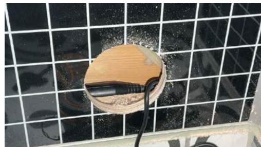
Måling av trefukt i lukket trekonstruksjon mellom bad og toalettrom.
