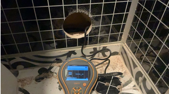
Måling av trefukt i lukket trekonstruksjon mellom bad og toalettrom.
