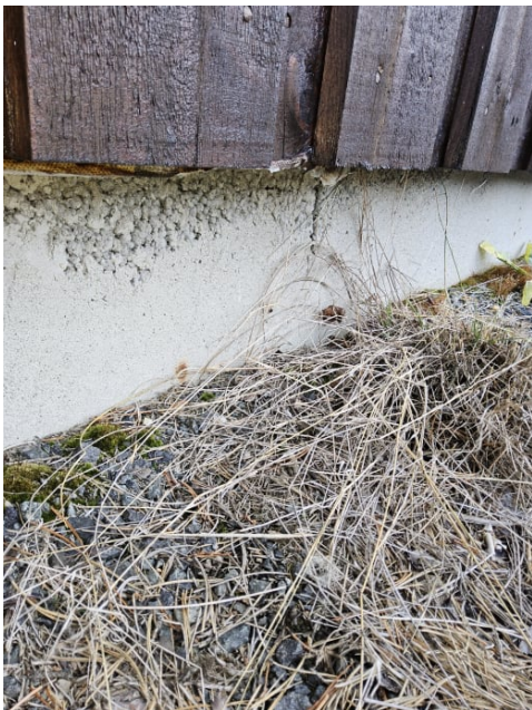
Bilde viser grunnmur.
