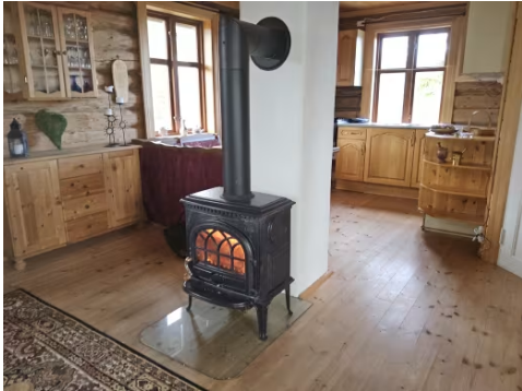
Bilde viser vedovn og pipe.
