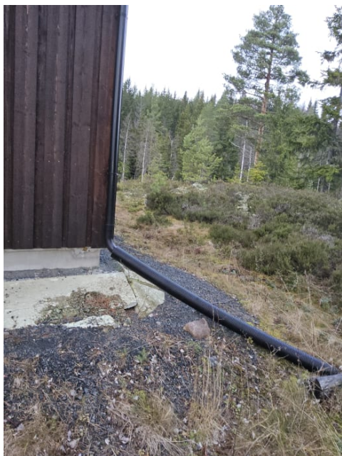
Bilde viser taknedløp.
