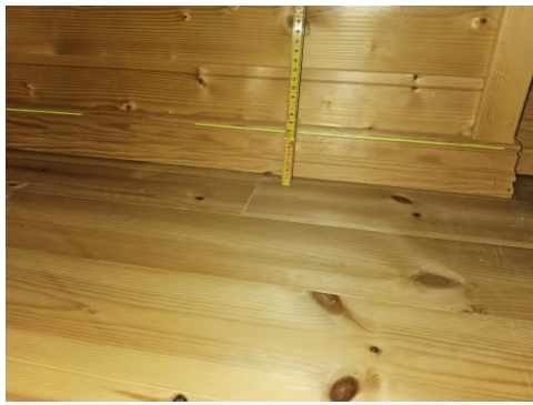
Bilde viser måling av etasjeskiller.
