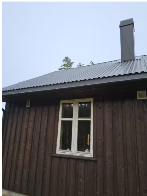
Bilde viser taktekking med lakkerte metallplater.
