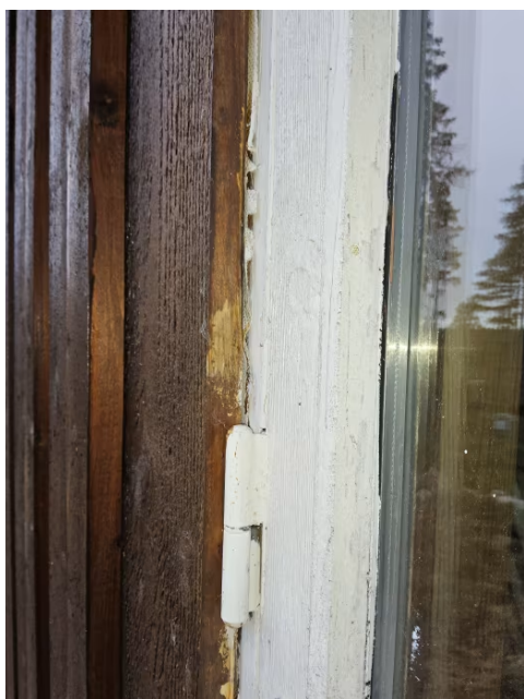
Bilde viser avslutning av kledning mot vindu.
