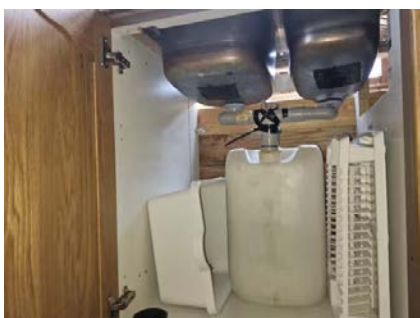
Bilde viser røropplegg under oppvaskkum på kjøkken.
