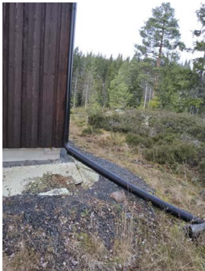
Bilde viser taknedløp.
