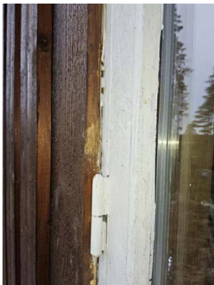
Bilde viser avslutning av kledning mot vindu.
