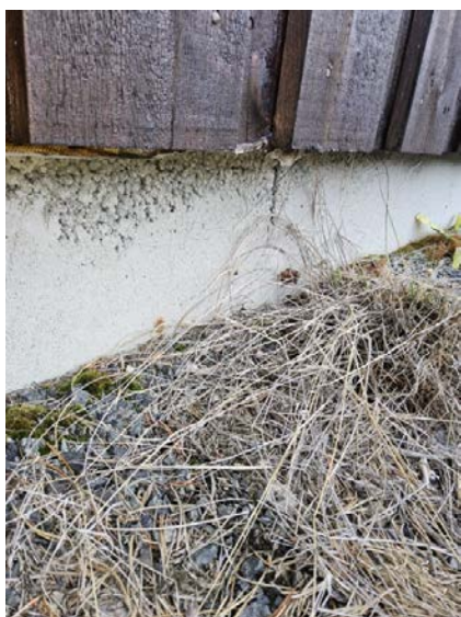
Bilde viser grunnmur.
