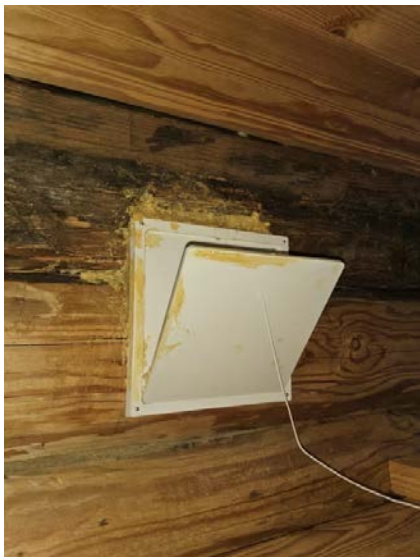
Bilde viser klaffventil i stue.
