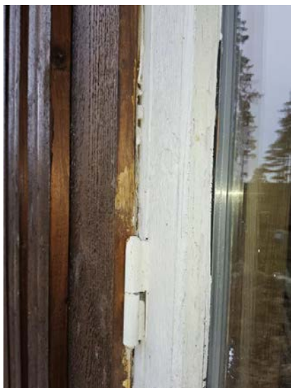
Bilde viser avslutning av kledning mot vindu.
