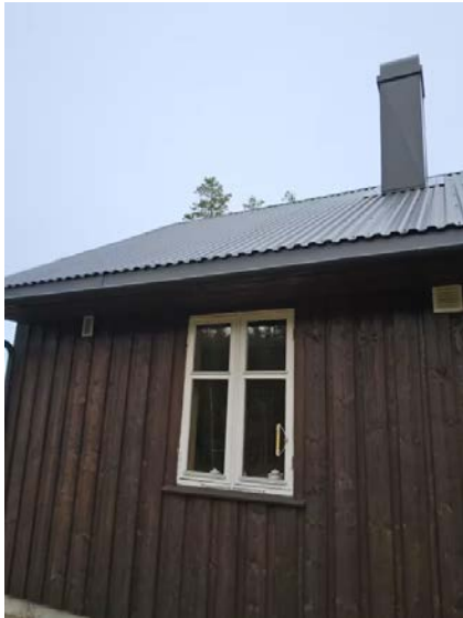
Bilde viser taktekking med lakkerte metallplater.
