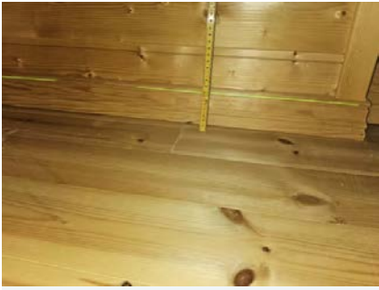
Bilde viser måling av etasjeskiller.
