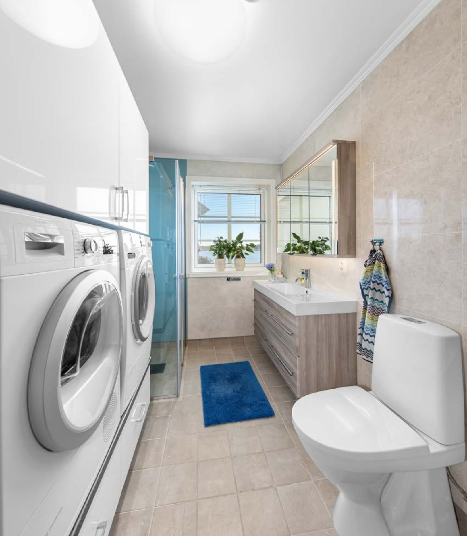
Bad/vaskerom i 1. etasje har gulv med fliser og vegger med våtromsplater. Det er opplegg til vaskemaskin og tørketrommel. Rommet inneholder wc, servant og dusjhjørne med glassvegger. Det er avtrekk via ventilasjonsanlegget.
