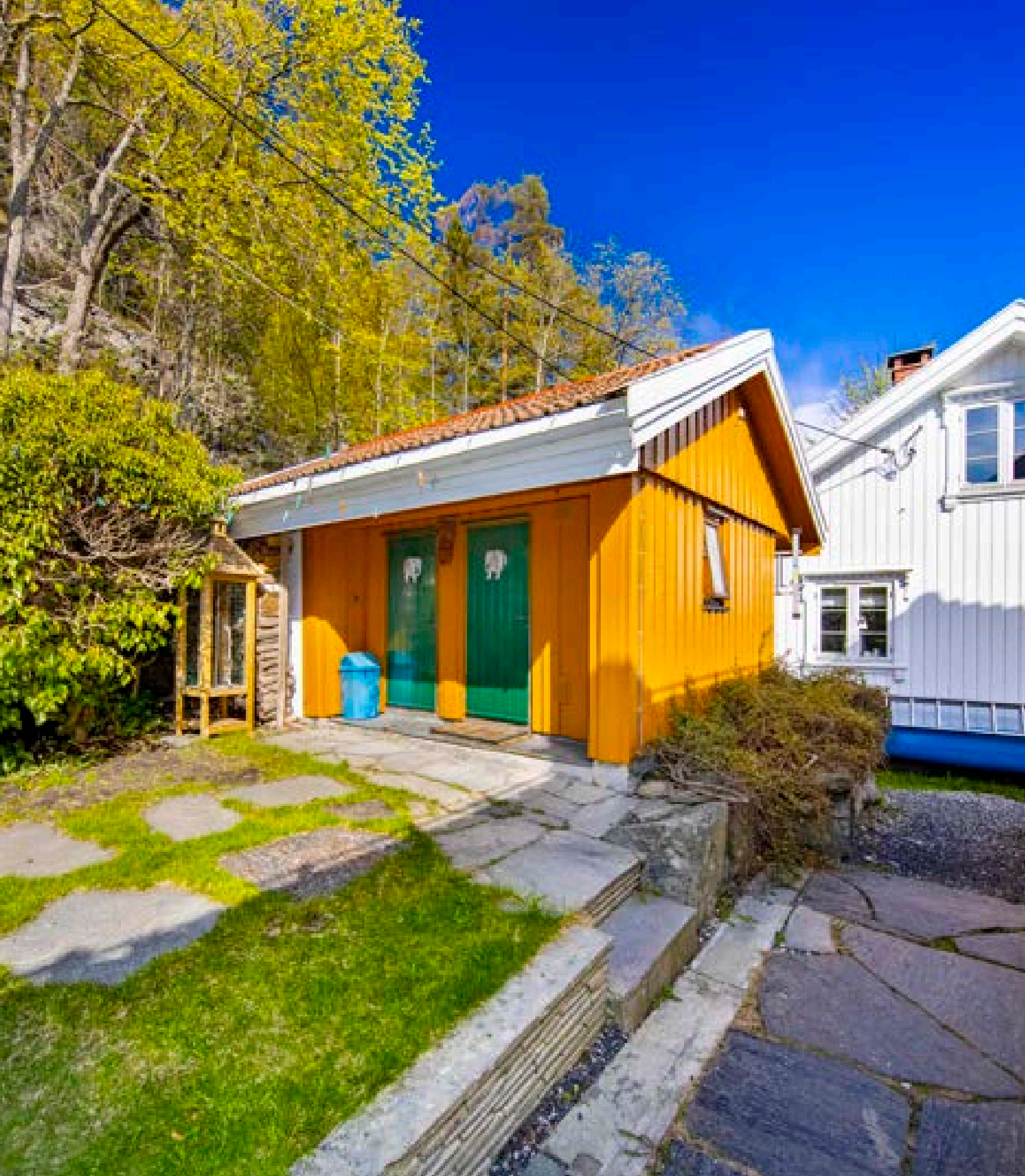
Vedbod/kjølerom er oppført rundt 1988 og inneholder bod, en liten gang/lagerrom og kjølerom.
