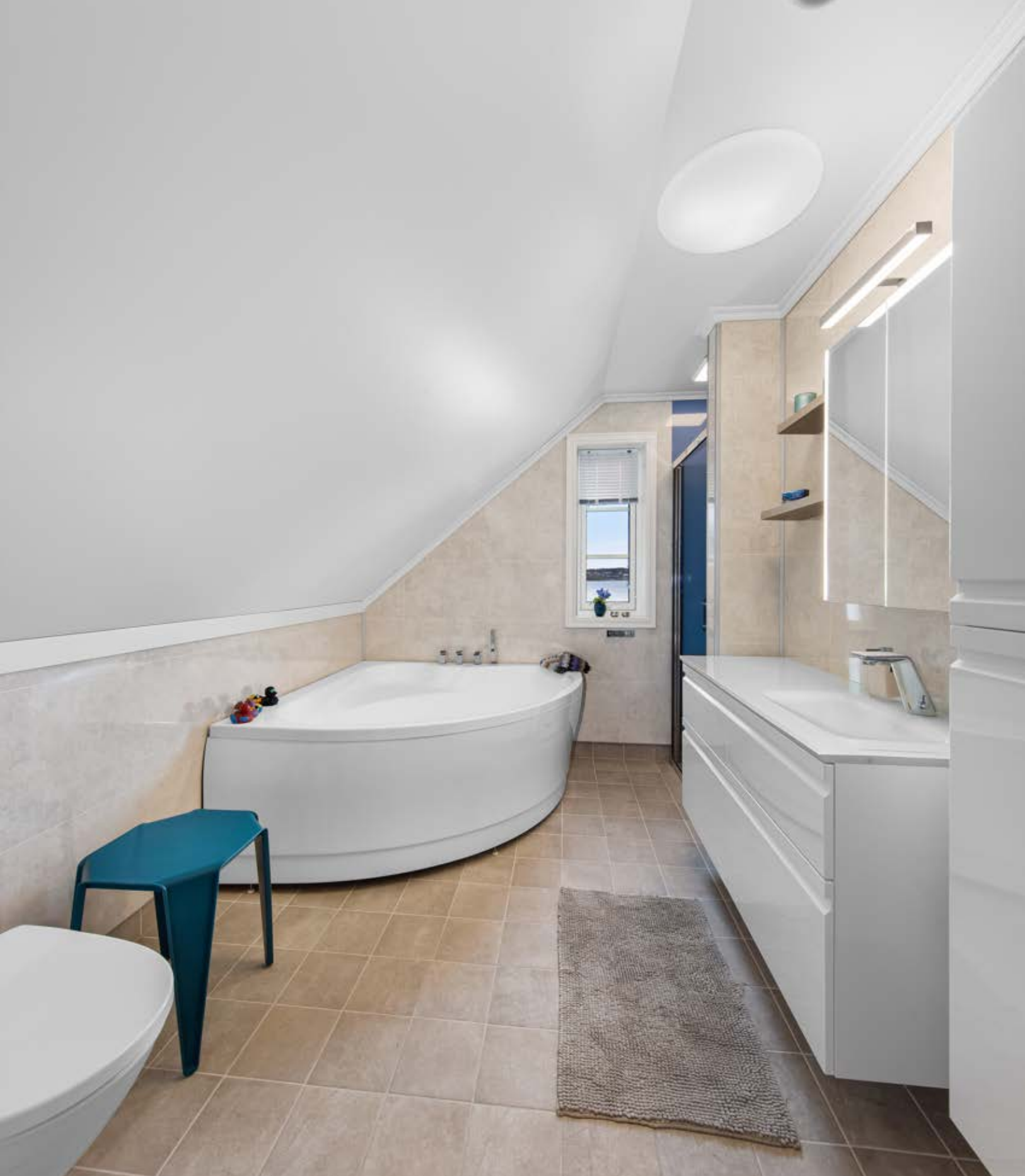
Badet i 2. etasje inneholder wc, servant, dusjnise og hjørnebadekar. Det er flislagt gulv og vegger med våtromsplater. Badet har avtrekk via ventilasjonsanlegget.
